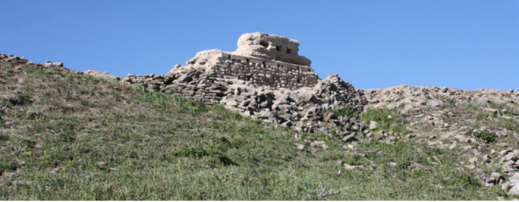
Östlicher Abschnitt der spätlisamischen Stadtmauer
