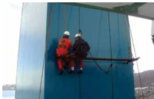
Figura 3. Trabajo en altura
