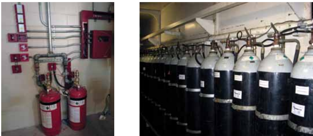
Figura 56. Disparo de un sistema fijo de CO 2
