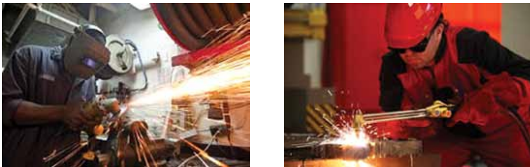
Figura 34. Trabajos en caliente
