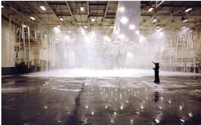
Figura 62. Sistema de tubería mojada
