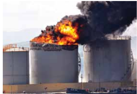
Figura 5. Incendio/explosión por electricidad estática
