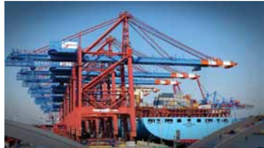
Figura 23. Gruas de carga y descarga
