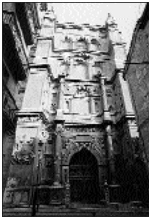
Figura 21. Vista general de la Portada del Perdón antes de la intervención
