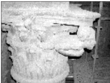
Figuras 23 a 26. Alteración de los materiales pétreos en la Portada del Perdón, formación de costras, descamaciones y fisuras en frisos, pináculos y capiteles
