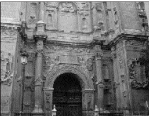
Figura 22. Vista de detalle del cuerpo bajo de la Portada del Perdón antes de la intervención
