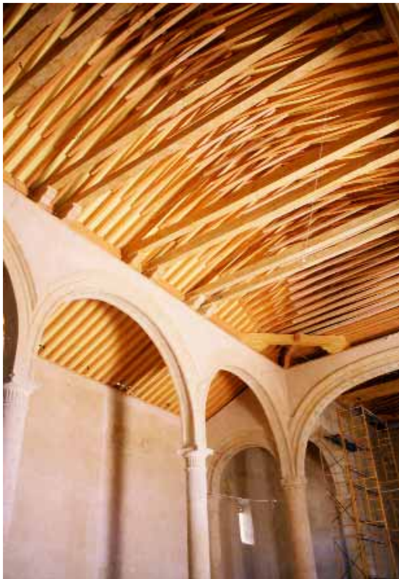
Nuevo artesanado de madera como estructura de soporte de la cubierta de la iglesia de Valdetorres de Jarama en Madrid. Foto: Latorre y Cámara arquitectos
