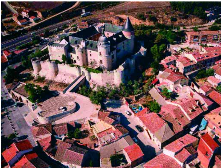
Vista aérea del archivo del año 1995 (fachadas SE y SO) cuando ya se han terminado las obras de reforma del ala NO para ubicación de las nuevas salas de Depósitos Documentales. Ya ha sido demolida la vivienda del archivero y se aprecia claramente la explanada y la escalera imperial del año 1949. Foto: T'knicos arquitectura-Estudio Mario Pírez
