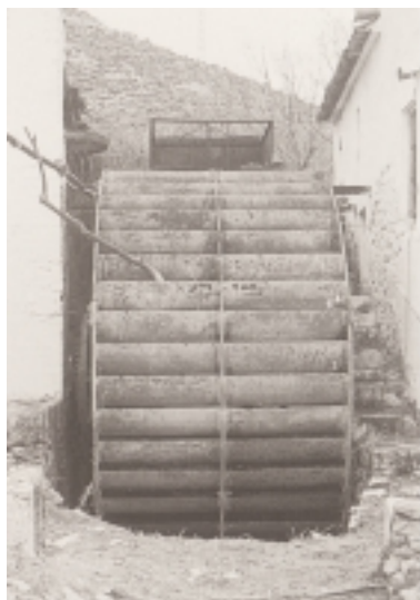
10. Rueda hidráulica de cajones o "voladera". Perteneció a la fábrica de hilados y tejidos de lana La Juanona. Fabricada en alguna de las fundiciones malagueñas del empresario Heredia
