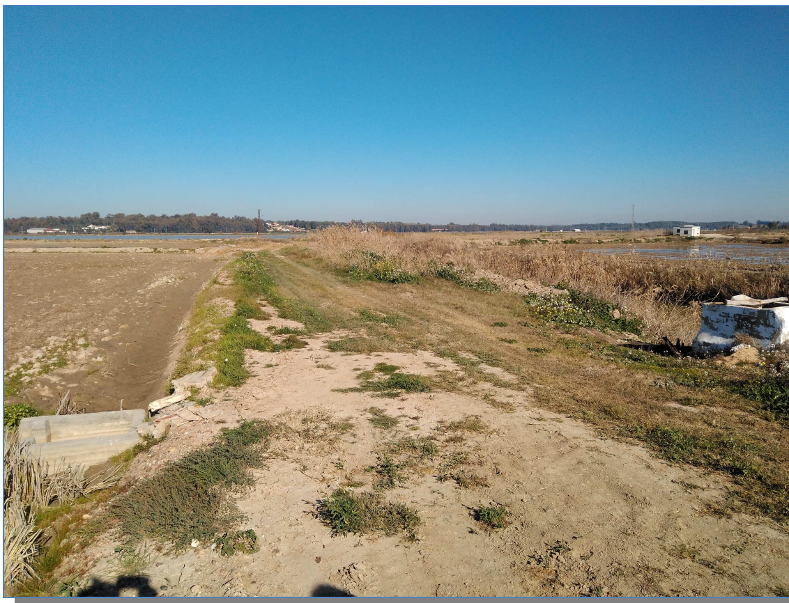
Figura 4. Entorno de la captación (trazado de la conducción de PVC de 125 mm).
