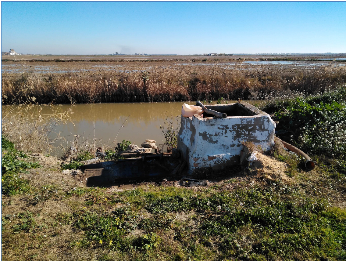
Figura 1. Losa de hormigón y arqueta de descarga.
