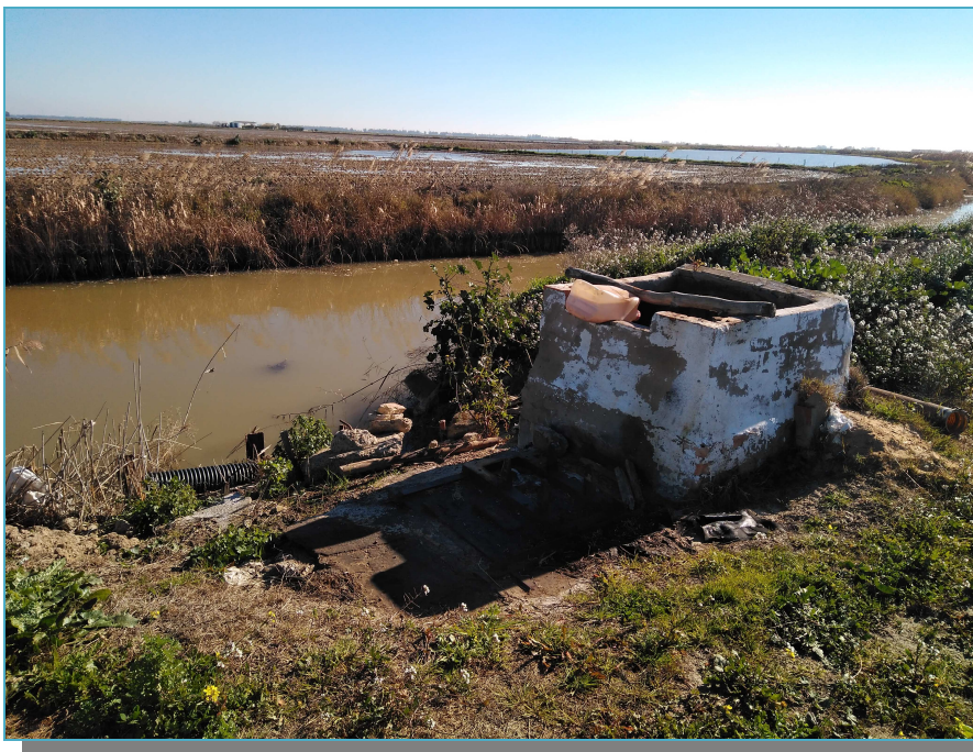
Figura 2. Obra de captación.
