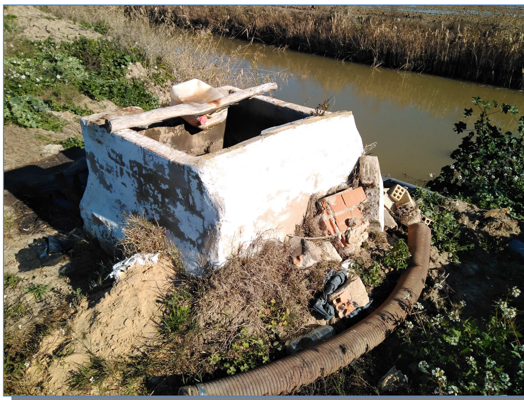
Figura 3. Arqueta de descarga del agua captada.
