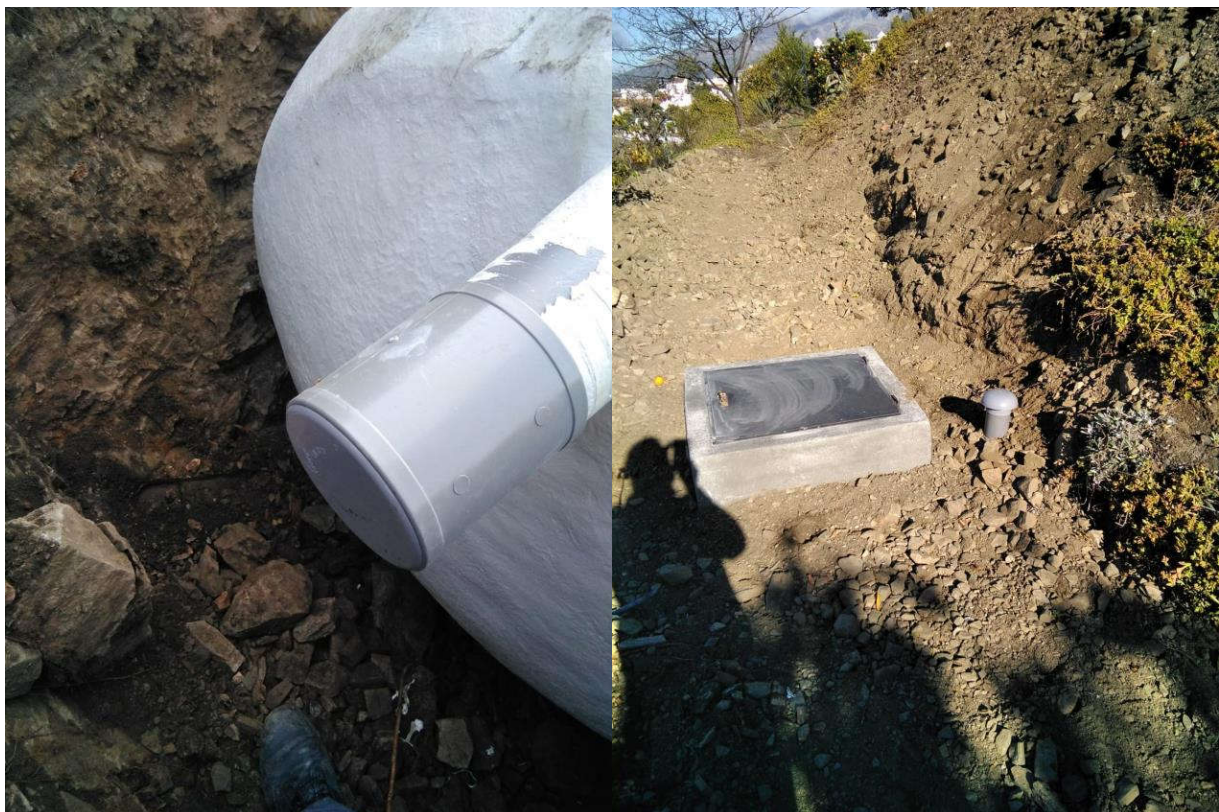
Imagen instalación fosa séptica con tapón en la salida para hacerla totalmente estanca
