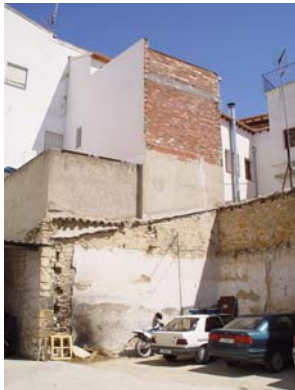
ESTADO PREVIO DEL ENTORNO DEL EDIFICIO HISTÓRICO
