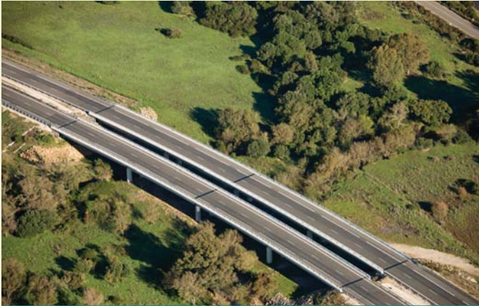
VIADUCTO SOBREDIMENSIONADO PARA LA PERMEABILIDAD DEL TERRENO.
