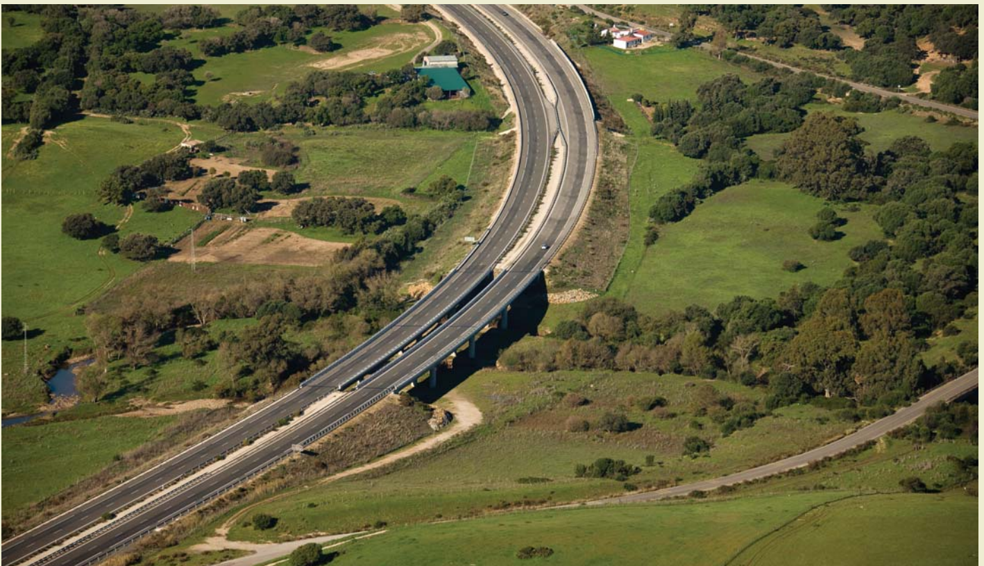
VIADUCTOS. ARRIBA, VIADUCTO SOBREDIMENSIONADO SOBRE UN ARROYO PARA EL PASO DE FAUNA. PÁGINA ANTERIOR, TRAZADO DE LA A-381.
