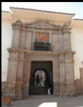
Marqueses de Valleumbroso
