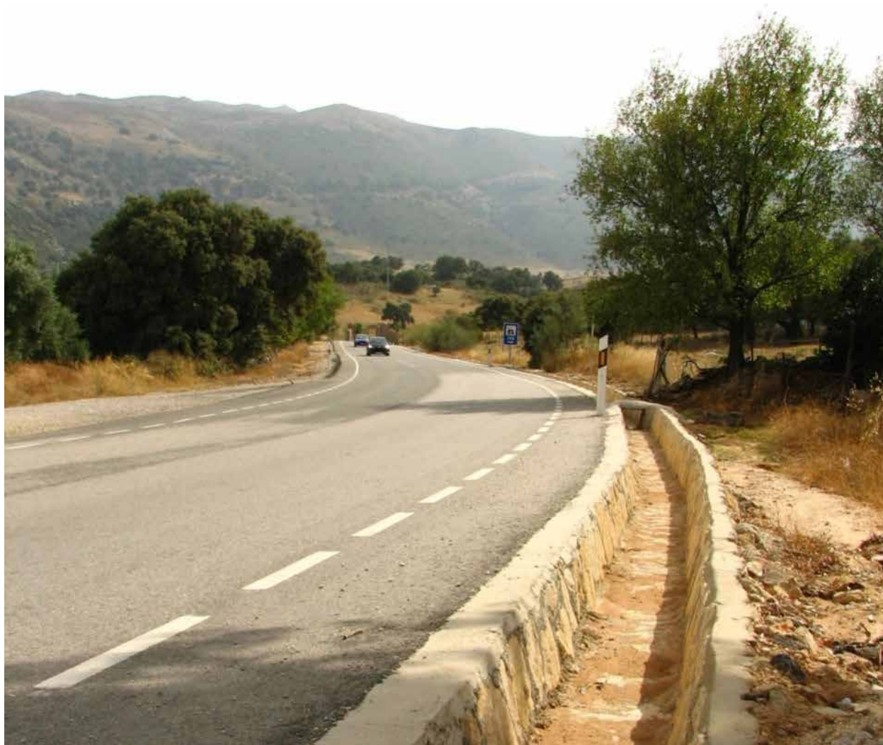
Es importante la limpieza y mejora de las obras de drenaje. Foto 87.
