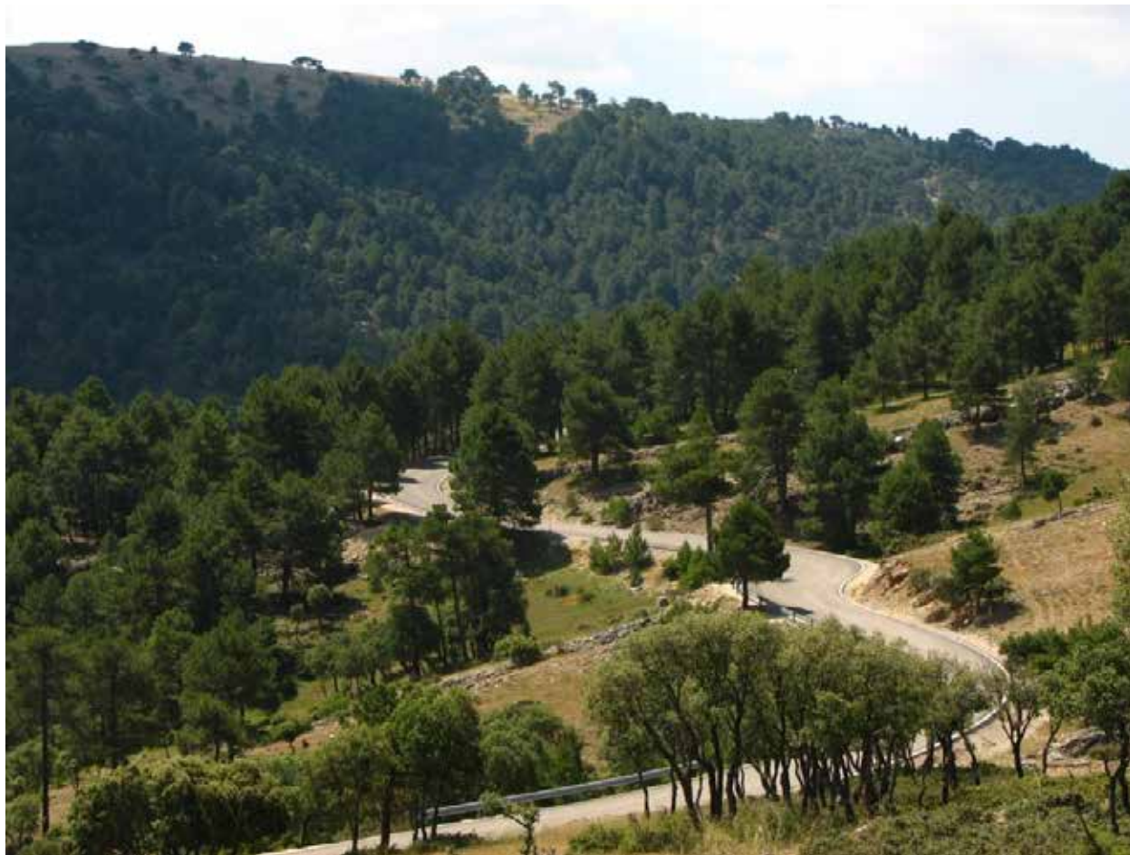
Tramo de la carretera paisajística A-317 que discurre por las Sierras de Cazorla, Segura y Las Villas. Hornos, Jaén. Foto 54.
