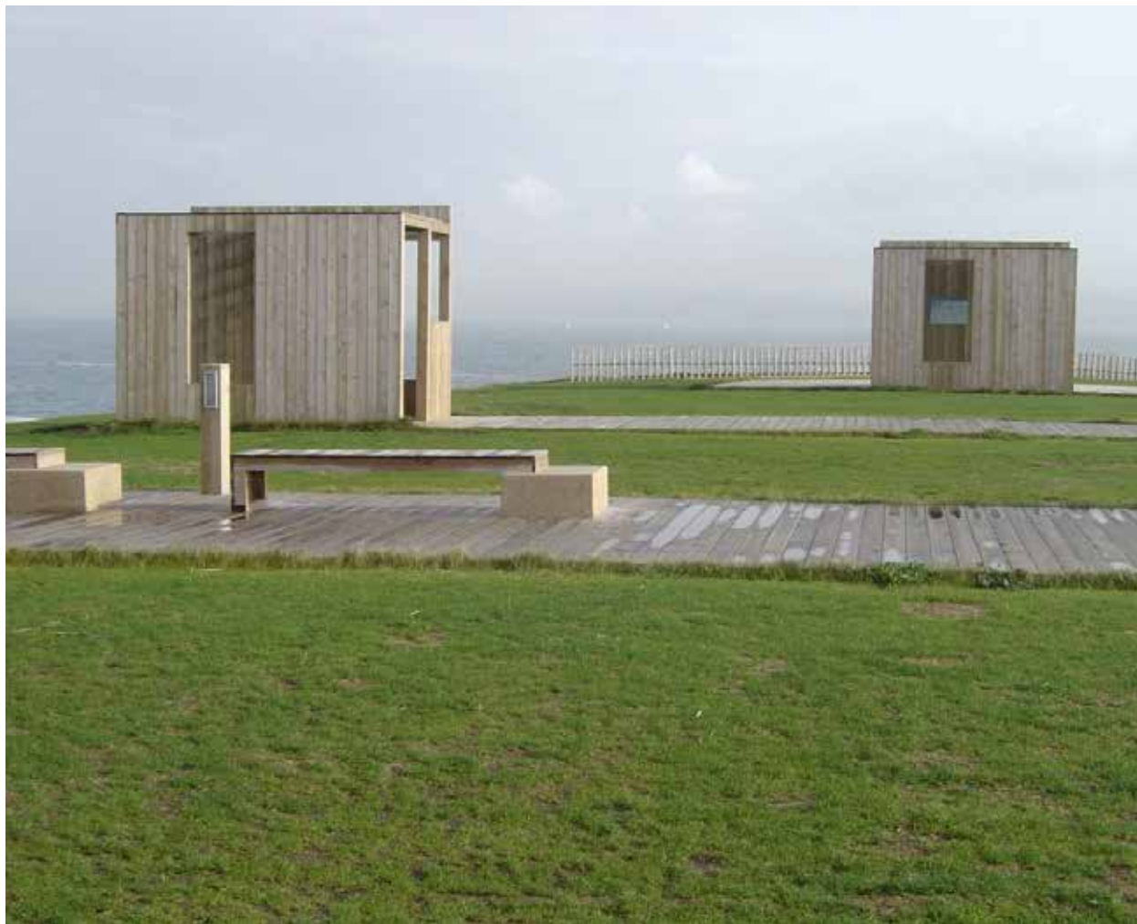
Elementos protectores instalados en el Rincón del Viento. Foto 89.
