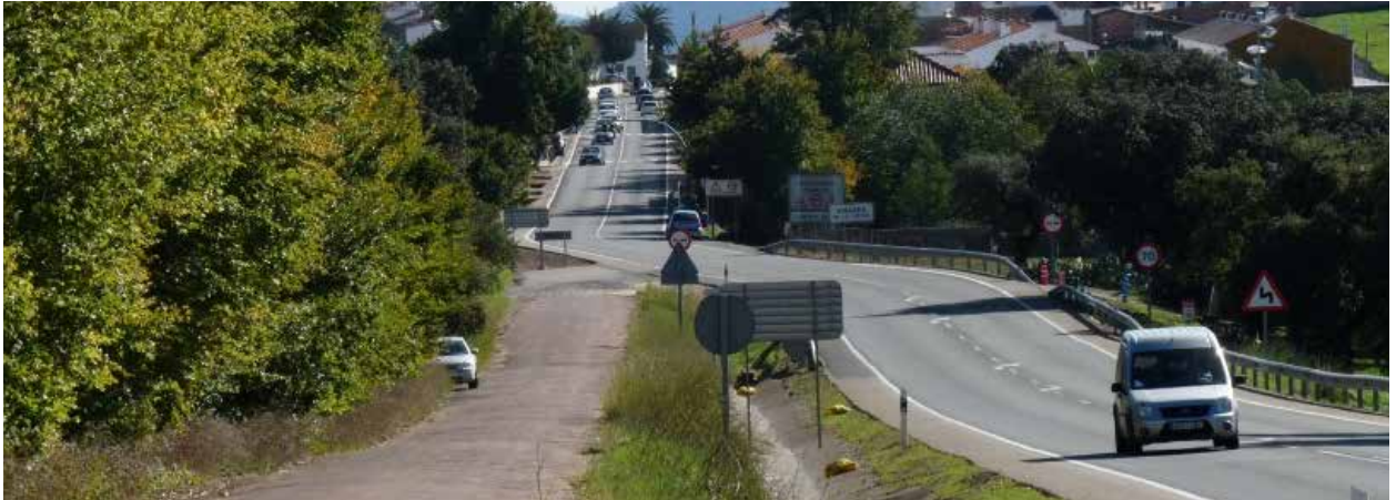
Antiguo trazado de una carretera próximo a un núcleo de población con aptitud para su adecuación como paseo lateral. Foto 83.
