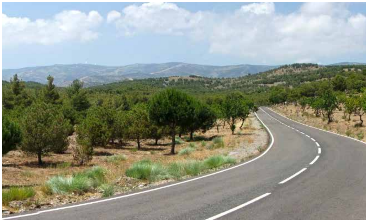
Tramo de la carretera paisajística de Las Menas y Calar Alto (A-1178). Almería. Foto 53.
