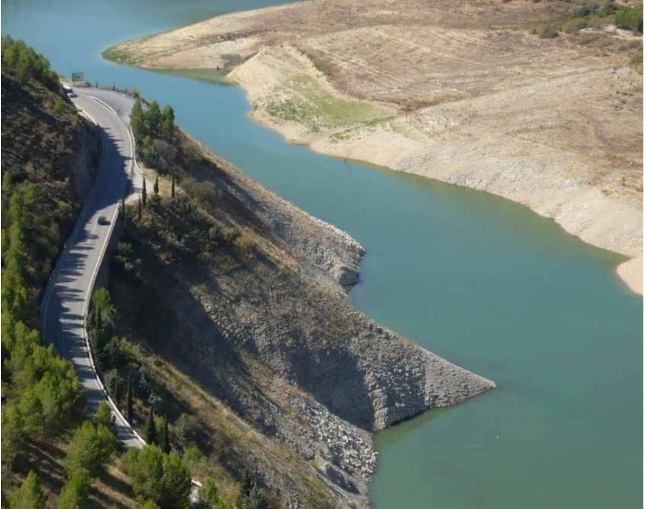
Ensanchamiento lateral de la calzada para facilitar la parada de los vehículos y la contemplación del embalse de Iznájar, en la provincia de Córdoba. Foto 93.
