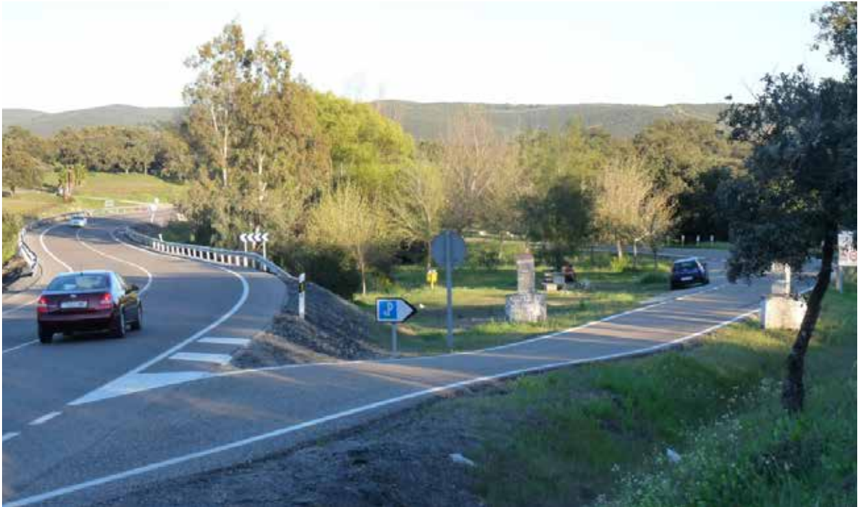
Área de descanso ubicada entre la calzada y un tramo abandonado del antiguo trazado de la carretera. Foto 96.
