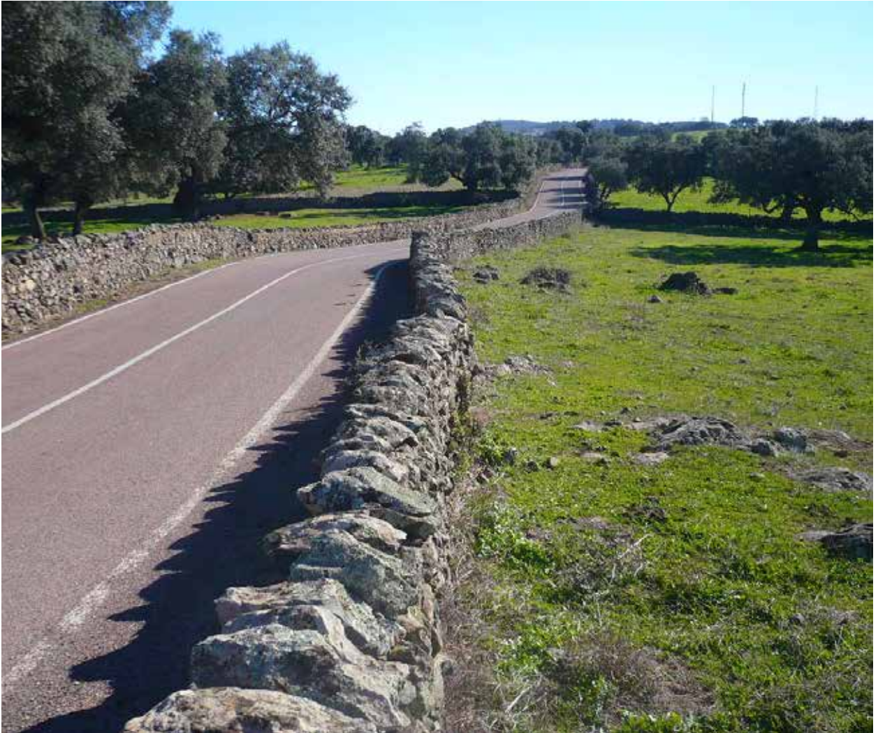
La conservación o restauración de ciertos elementos tradicionales como los muros de piedra confieren carácter al paisaje de la carretera. Foto 86.
