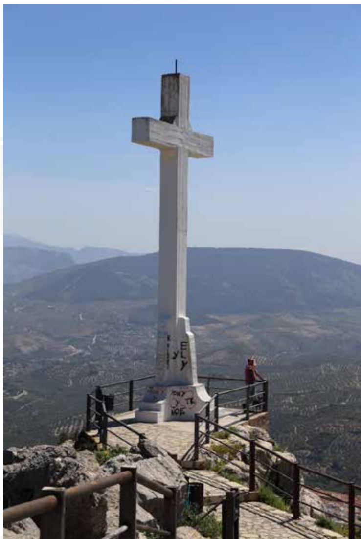
Mirador del castillo de Santa Catalina (Jaén). Barandilla protectora en la plataforma de observación. Foto 92.
