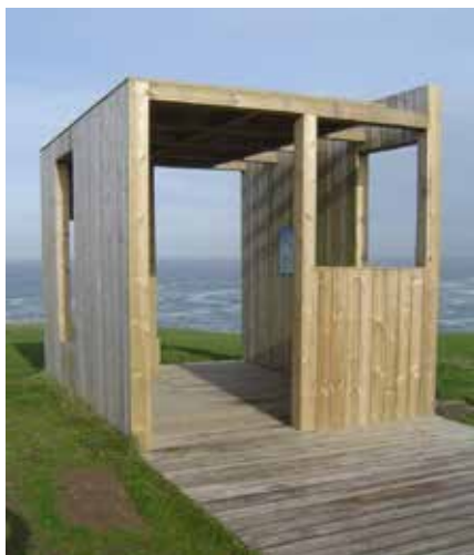
Detalle de elementos protectores frente al viento y la insolación. Foto 90.
