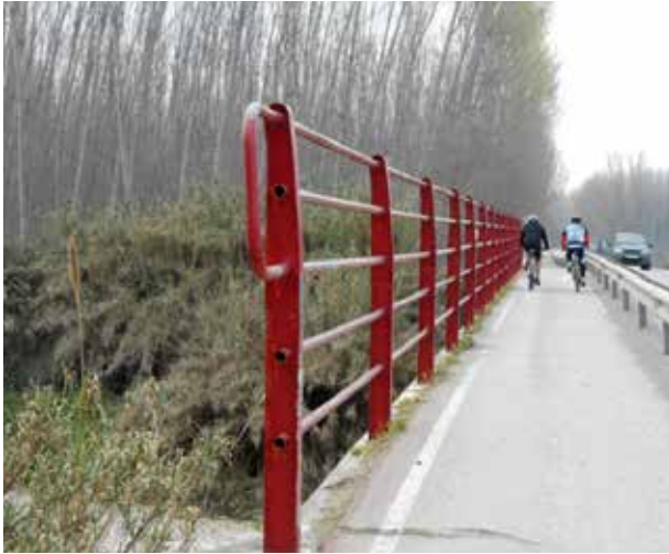
Carril bici contiguo a la calzada, separado de la misma mediante barreras de seguridad. Foto 101.
