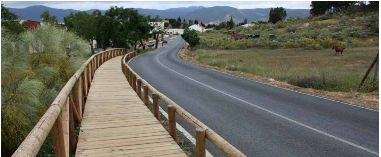
Paseo lateral acondicionado contiguo a la calzada. Foto 84.
