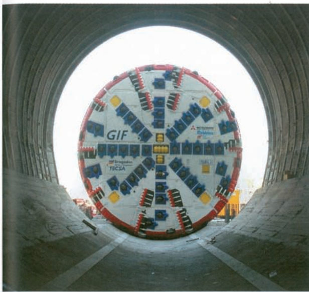
Foto 4. Cabeza de corte de la TBM del túnel Este desde el interior del emboquille. Photo 4. Cutting head of the TBM for the East tunnel from inside the entrance.
