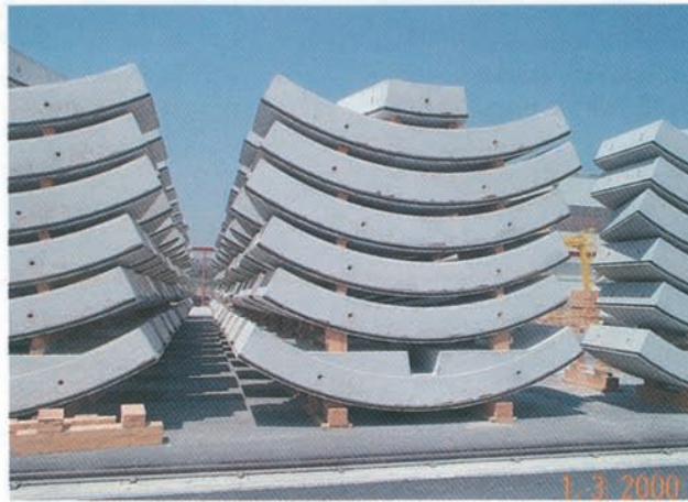
Foto 6. Anillo compuesto por 7 dovelas en la zona de acopio de la explanada sur. Photo 6. Ring composed of 7 segments in the stockpiling area of the south site.
