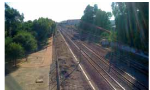
105. Córdoba. Viaducto sobre el ferrocarril: perspectiva urbana hacia el oeste
