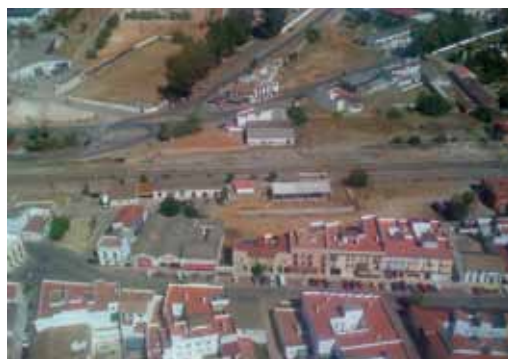
Vista aérea del entorno ferroviario de Posadas: la actual estación, el nuevo edificio en construcción y la explanada de aparcamiento de camiones exterior al recinto
