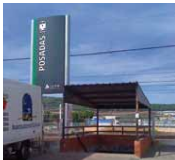
208. Posadas. Paso peatonal bajo las vías a la salida de la estación
