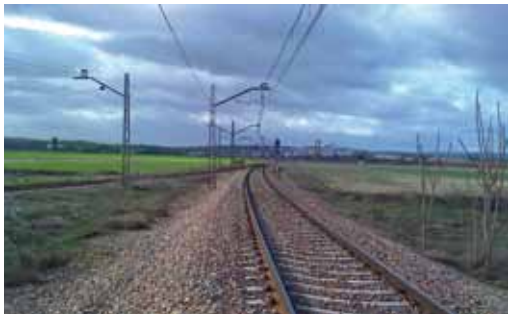
37. El Carpio. Entrada de un ramal ferroviario a la antigua azucarera
