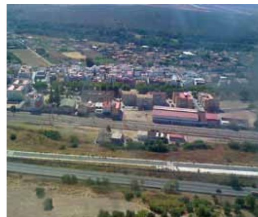
Vista aérea de la travesía ferroviaria
