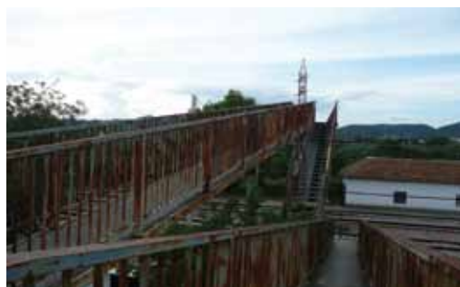
92. Alcolea. Pasarela peatonal
