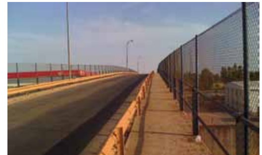
123. Complejo ferroviario de El Higerón. Viaducto sobre las vías
