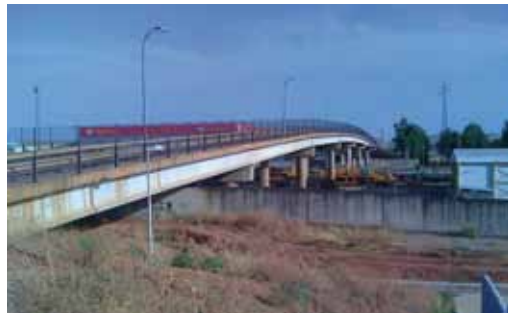
122. Complejo ferroviario de El Higerón. Viaducto sobre las vías
