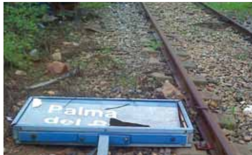
257. Palma del Río. Señalización abandonada
