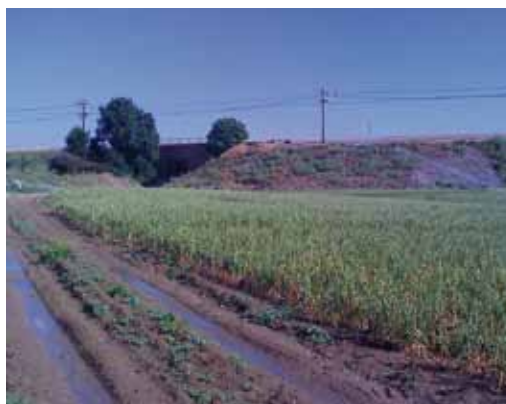
Antiguo puente del ferrocarril sobre carretera local
