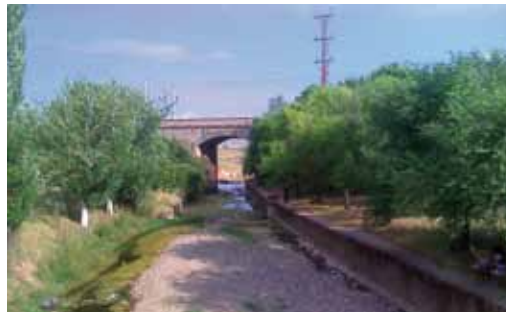
101. Córdoba. Paso del ferrocarril sobre el arroyo Pedroches
