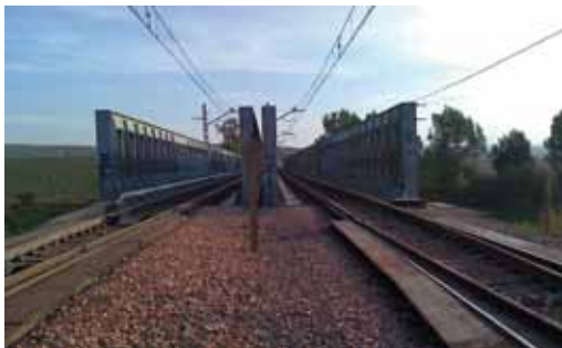
118. Córdoba. Puente ferroviario sobre el Guadalquivir (línea de Málaga)
