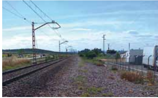
11. Villa del Río. Salida oeste
