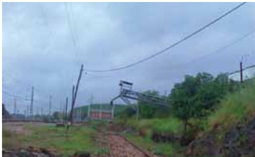
256. Palma del Río. Antiguas instalaciones ferroviarias en el recinto de la estación
