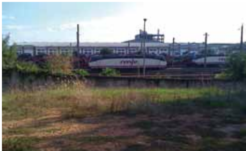
121. Complejo ferroviario de El Higerón. Tapia de separación con el entorno urbano
