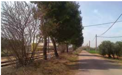
70. Villafranca de Córdoba. Carretera de acceso a la estación
