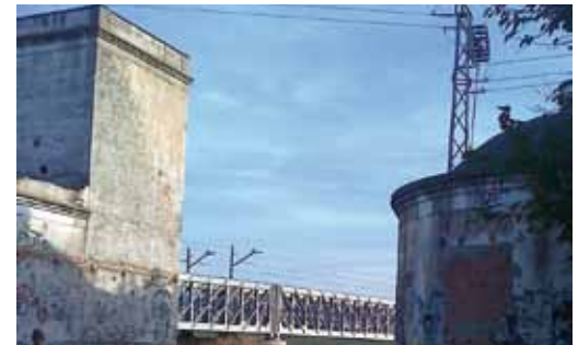
120. Córdoba. Puente ferroviario sobre el Guadalquivir (línea de Málaga)
