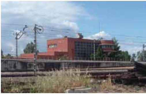
Puesto de control
