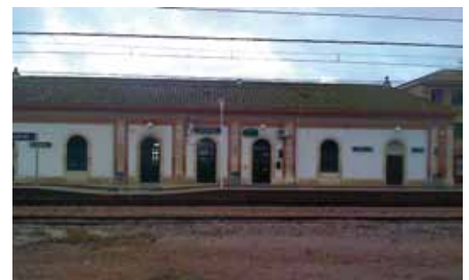
249. Palma del Río. Edificio de la estación
