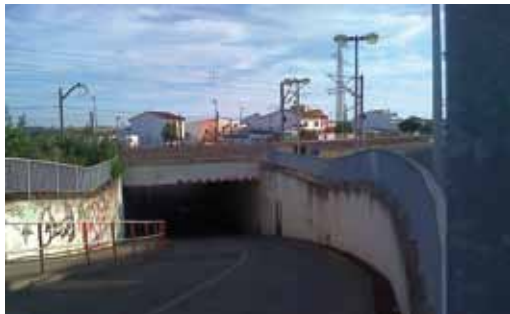
160. Villarrubia. Paso rodado con acerado bajo el ferrocarril
