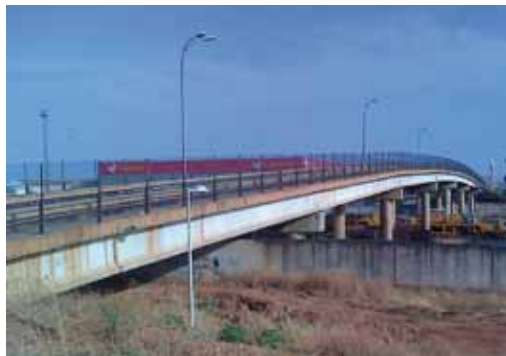
Desde un puente habilitado como mirador pueden observarse los movimientos y las actividades ferroviarias
