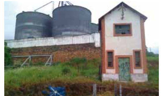
246. Palma del Río. Depósitos y otras instalaciones adyacentes a la estación
