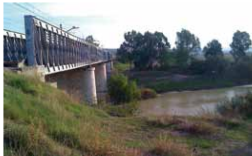
119. Córdoba. Puente ferroviario sobre el Guadalquivir (línea de Málaga)
