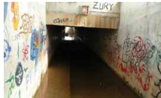
174. Almodóvar del Río. Paso bajo las vías
