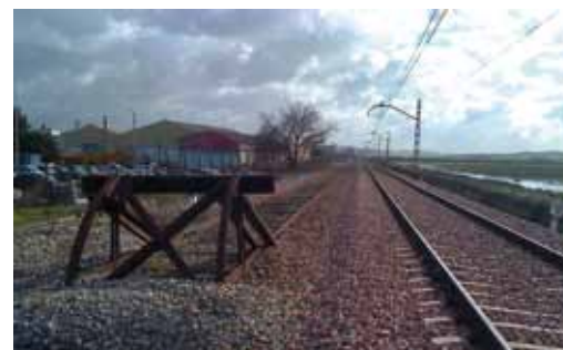
81. Alcolea. Ramal del polígono industrial
