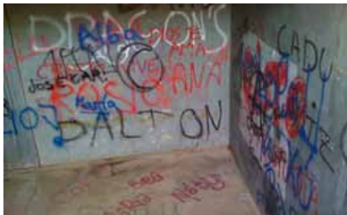
206. Posadas. Paso peatonal bajo las vías a la salida de la estación
