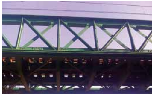
230. Hornachuelos. Puente metálico sobre el río Bembézar
