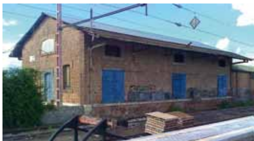
¿Se pueden considerar inservibles instalaciones que han sido útiles hasta ayer?
