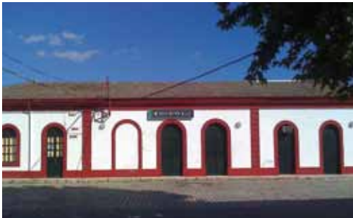
4. Villa del Río. Edificio de la estación y aparcamiento
