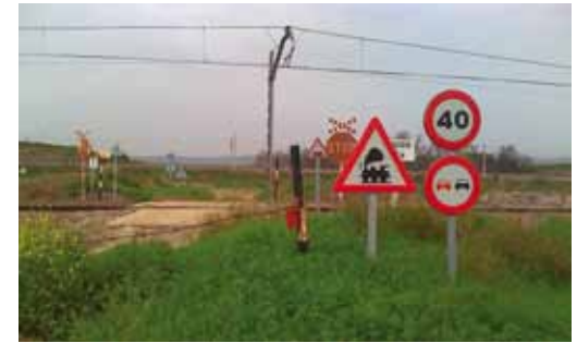
216. Entre Posadas y Hornachuelos. Pasos de caminos y accesos a fincas
