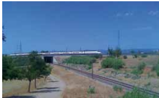
98. Córdoba. Cruce de los trazados de AVE y convencional en las inmediaciones de la ciudad
