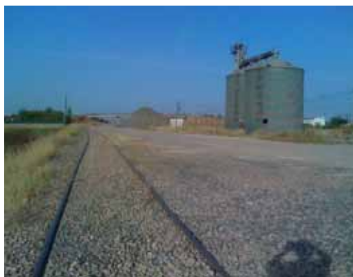
Un ramal para acopio de material. Higuera de la Puebla
