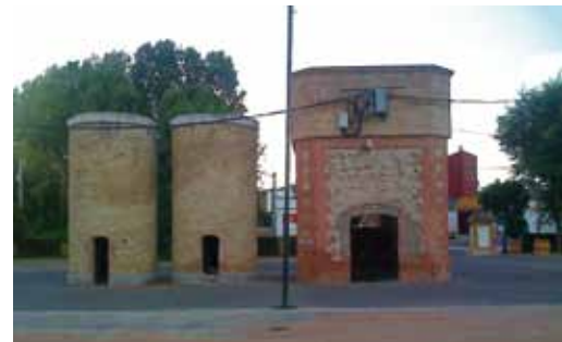
171. Almodóvar del Río. Antiguos depósitos en el recinto de la estación
