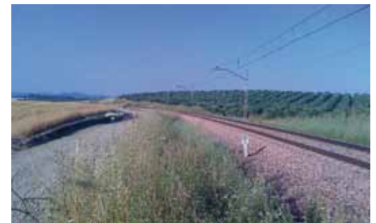
21. Montoro. Camino hacia el túnel
