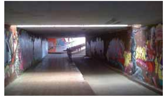
156. Villarrubia. Paso peatonal bajo las vías
