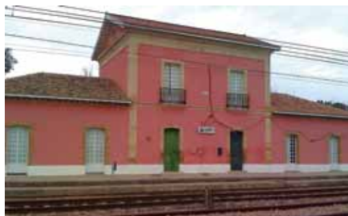
224. Hornachuelos. Edificio de la estación
