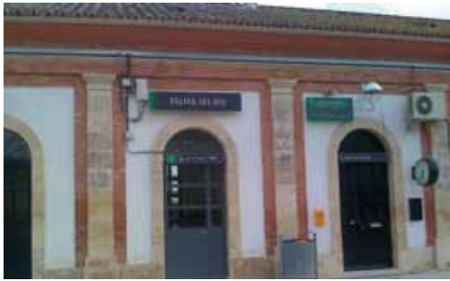
250. Palma del Río. Edificio de la estación
