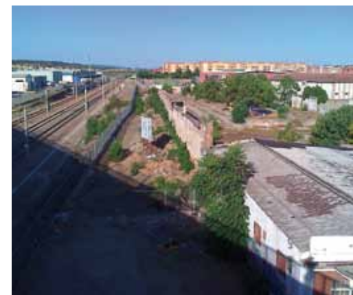
La imprescindible intervención en unos bordes muy deteriorados y con un fuerte impacto visual
