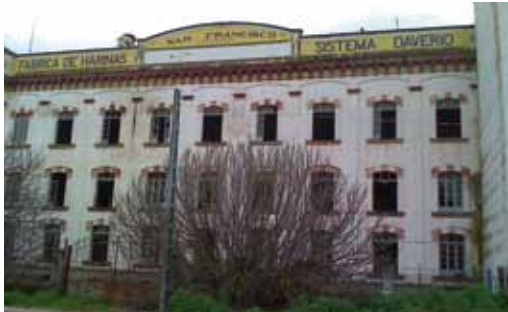
49. El Carpio. Antigua fábrica de harinas junto a la estación
