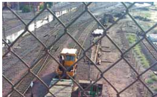
125. Complejo ferroviario de El Higerón. Vista del recinto y las maniobras de los trenes desde el viaducto
