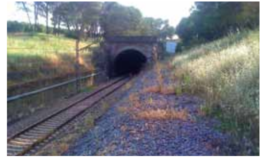
24. Montoro. Accesos del túnel
