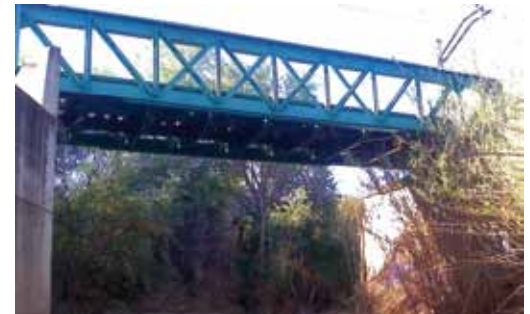
231. Hornachuelos. Puente metálico sobre el río Bembézar
