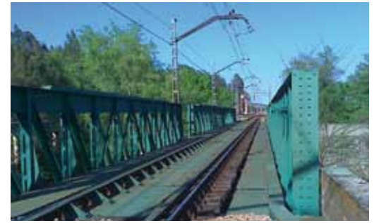
228. Hornachuelos. Puente metálico sobre el río Bembézar
