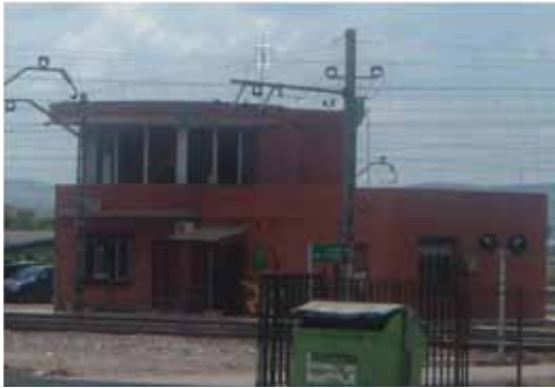
Edificio de formación de trenes
