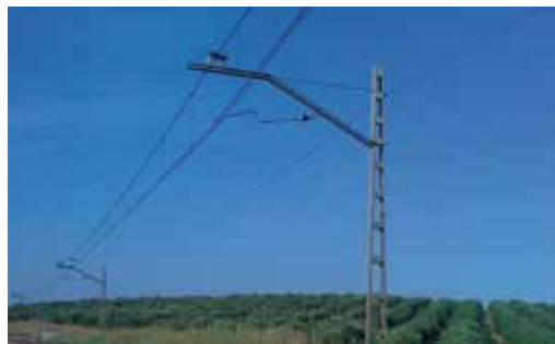
20. Montoro. Camino hacia el túnel
