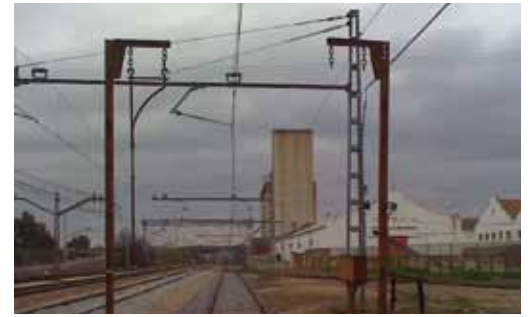
48. El Carpio. Antiguas instalaciones en la playa de vías
