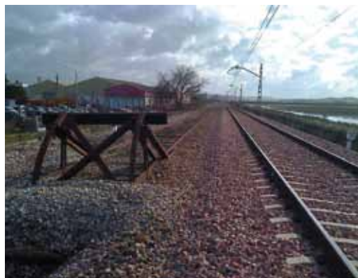
Recuperación de las conexiones ferroviarias con el polígono industrial de Alcolea
