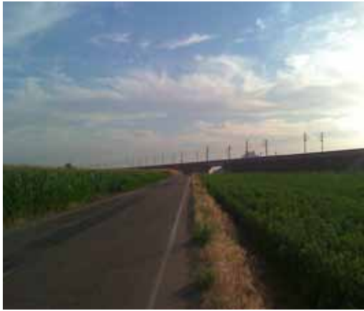
En algunos casos el daño hecho al paisaje no se puede reparar con paisajismo: el talud de la infraestructura ferroviaria de Alta Velocidad hace de antifaz frente a Almodóvar
