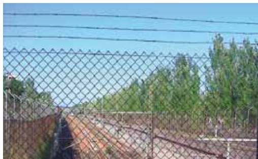
113. Córdoba. La travesía ferroviaria en cajón deprimido. Zona este
