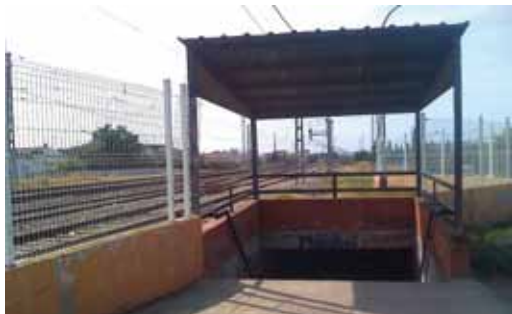
205. Posadas. Paso peatonal bajo las vías a la salida de la estación
