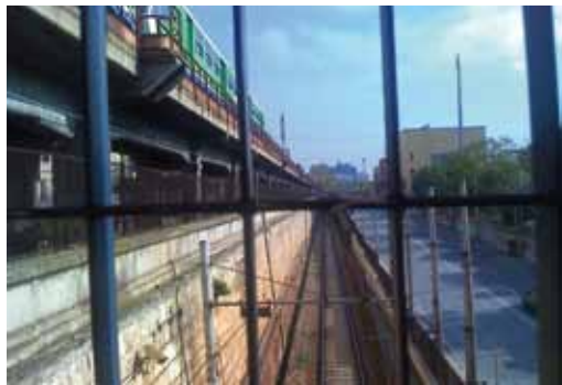
Diversas líneas a distinto nivel en la travesía urbana de Bari. Una potente imagen visual
