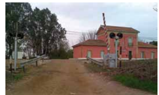
225. Hornachuelos. Paso a nivel junto a la estación
