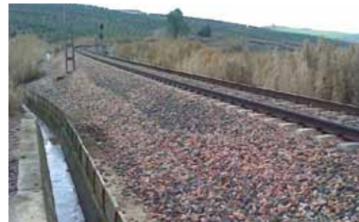
72. Villafranca de Córdoba. Canalización paralela al ferrocarril
