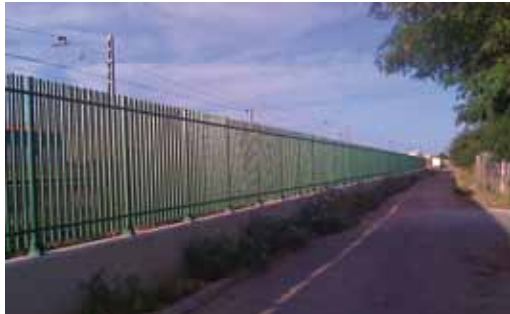
157. Villarrubia. Vallado de separación del ferrocarril
