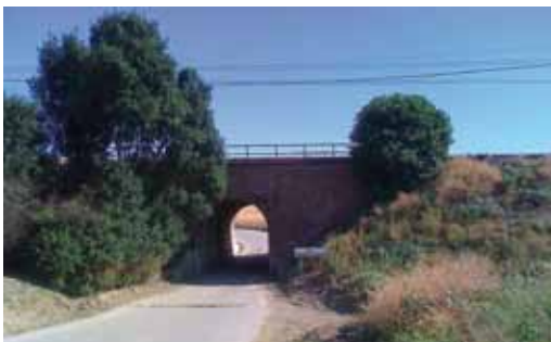
31. Pedro Abad. Antiguo puente bajo del ferrocarril
