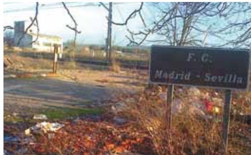
41. El Carpio. Paso interrumpido de un camino próximo a la población
