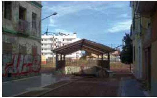
155. Villarrubia. Paso peatonal bajo las vías
