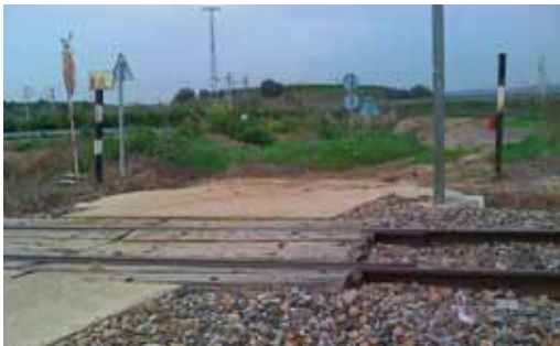
217. Entre Posadas y Hornachuelos. Pasos de caminos y accesos a fincas
