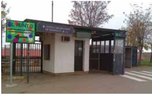
94. Campus Universitario de Rabanales. Acceso al apeadero
