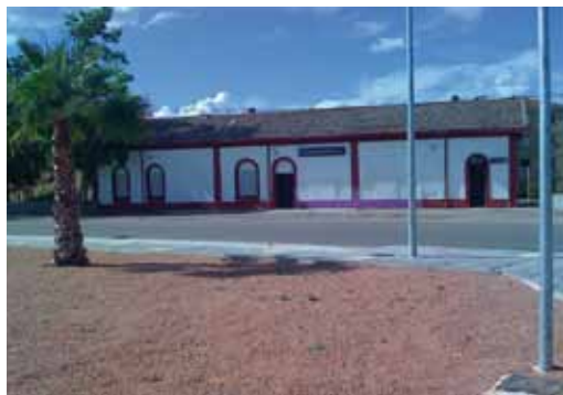
Espacios exteriores al recinto ferroviario en El Carpio
