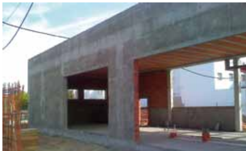
191. Posadas. Construcción de un nuevo edificio para la estación a escasos metros de la actual
