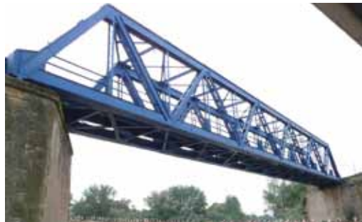
185. Almodóvar del Río. Puente sobre el río Guadiato
