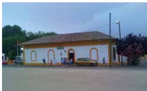
164. Almodóvar del Río. Fachada interior de la estación
