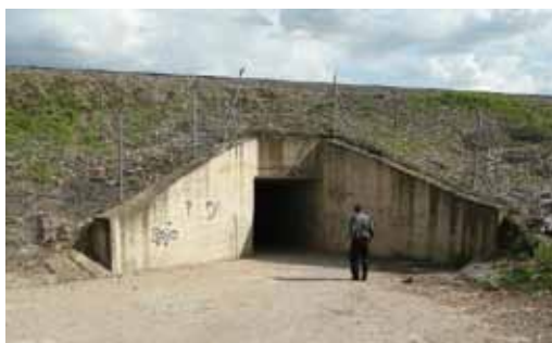
176. Almodóvar del Río. Paso bajo las vías
