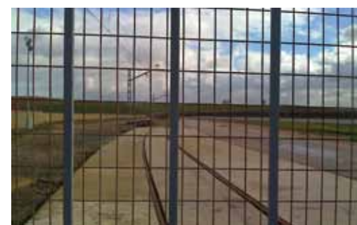
Recuperación y reutilización de los ramales que penetraban en los recintos industriales
