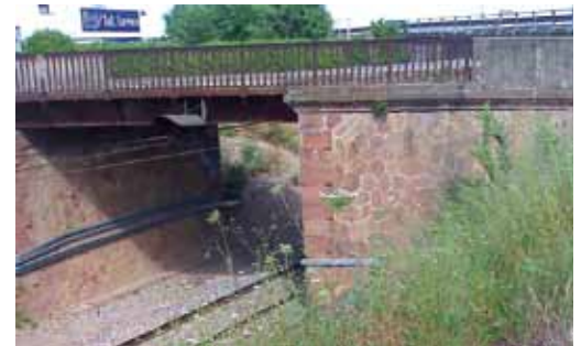
54. El Carpio. Puente salida oeste de la travesía urbana del ferrocarril
