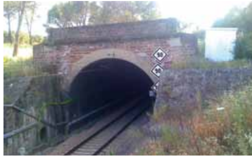
26. Montoro. Accesos del túnel
