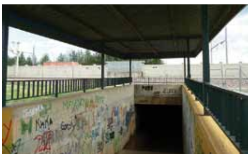
175. Almodóvar del Río. Paso bajo las vías
