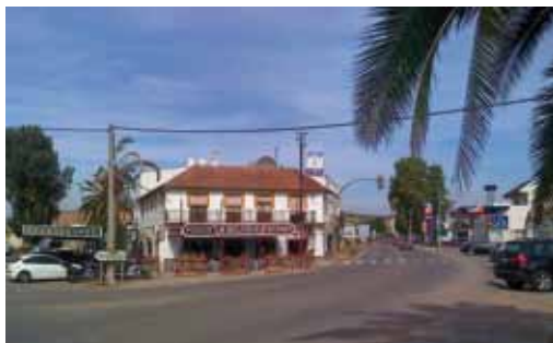
209. Posadas. Tramo de travesía urbana frente a la estación
