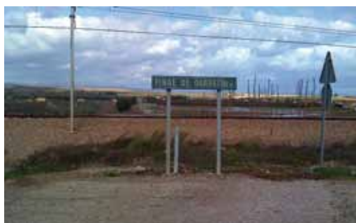
58. El Carpio. Intersección del ferrocarril con una vía pecuaria
