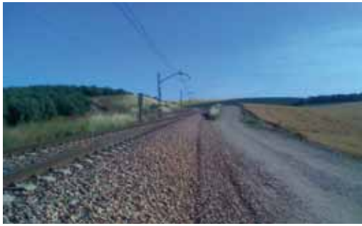
22. Montoro. Camino hacia el túnel
