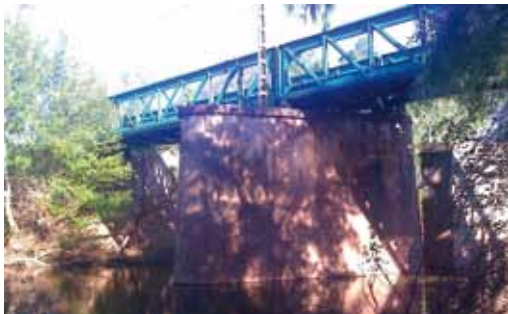
229. Hornachuelos. Puente metálico sobre el río Bembézar
