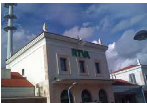
Una forma discutible de intervención: la implantación de usos totalmente ajenos en viejos contenedores. La antigua estación de Córdoba
