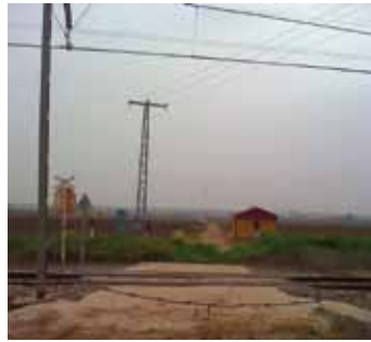
215. Entre Posadas y Hornachuelos. Pasos de caminos y accesos a fincas
