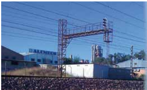
109. Córdoba. Señalización en travesía urbana
