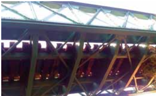
232. Hornachuelos. Puente metálico sobre el río Bembézar
