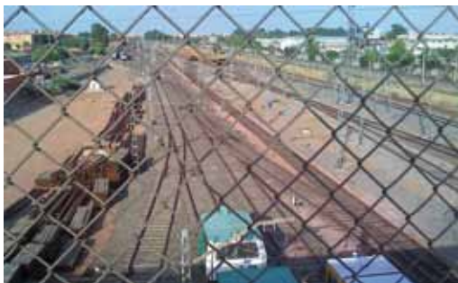
124. Complejo ferroviario de El Higerón. Vista del recinto y las maniobras de los trenes desde el viaducto
