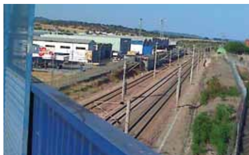
104. Córdoba. Vista hacia el este desde el viaducto sobre el ferrocarril
