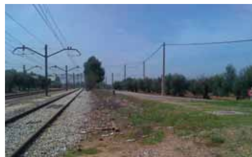
69. Villafranca de Córdoba. Carretera de acceso a la estación
