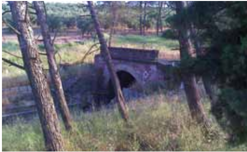
25. Montoro. Accesos del túnel
