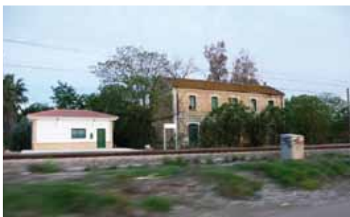
79. Los Cansinos. La estación desde la carretera
