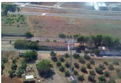
Una estación en las inmediaciones de un polígono industrial. Villafranca de Córdoba
