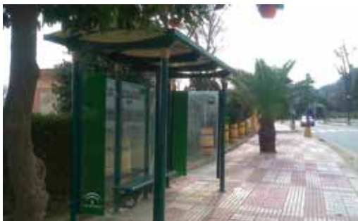
172. Almodóvar del Río. Cerramiento entre calle y recinto de la estación
