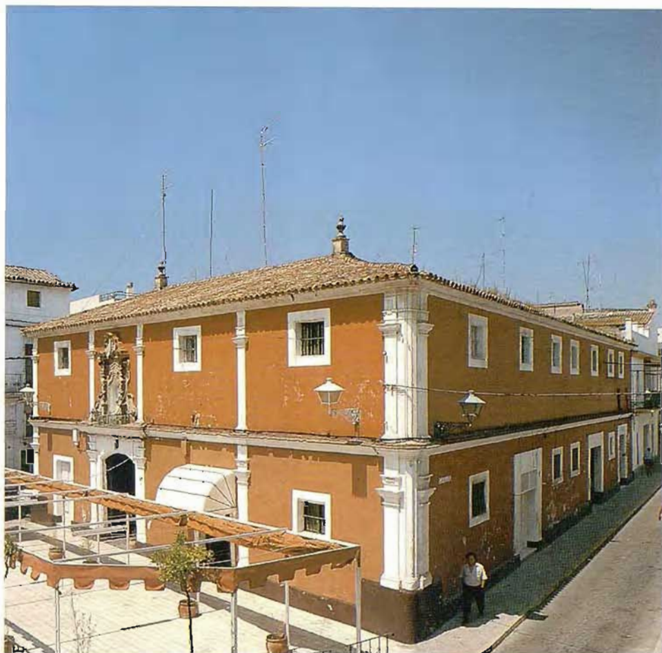
Alzado principal y vista general del antiguo edificio de la cilla.
