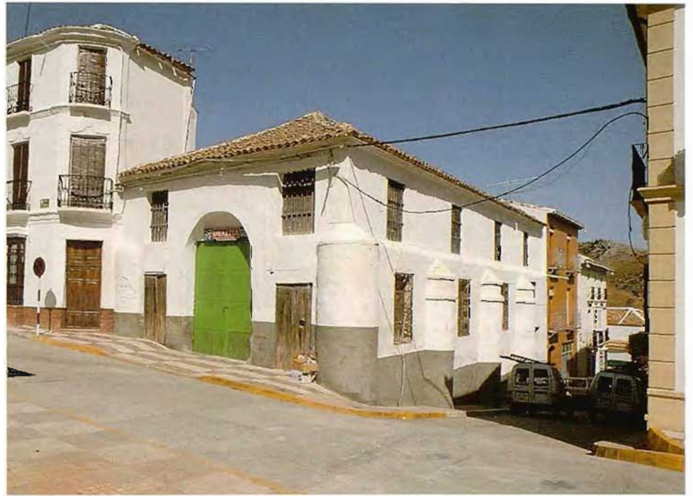
Plano de Cañete la Real y sus inmediaciones, incluido en el Diccionario Geográfico de Tomás López, en el que aparece la calle del pósito. Fines del XVIII. Biblioteca Nacional. Manuscrito 7.303. Vista del granero de Cañete, donde se aprecia el uso de contrafuertes circulares.
