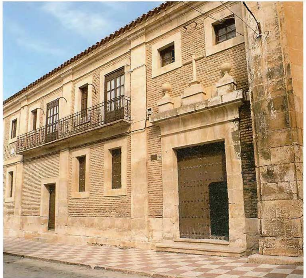
Edificio utilizado como Tercia del Marqués tras su traslado desde la Tercia Vieja.
