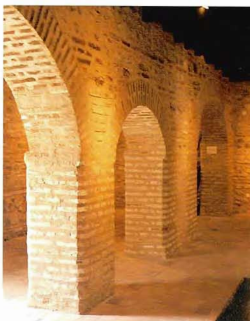
Interior de la planta baja y vista de la fachada, en la que se observa el antiguo acceso a planta alta. Planta alta del edificio del pósito.
