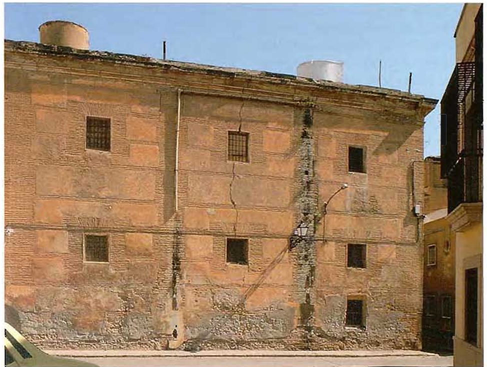
Casa del Granero. Fachada reformada en este siglo y alzado posterior donde se observa la fábrica mudéjar.
