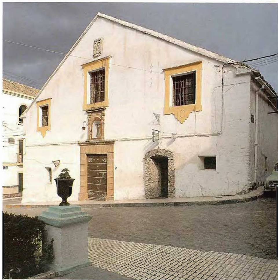
Alzado principal y vista exterior.
