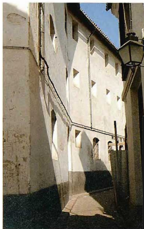
Vistas exteriores de la tercia de Córdoba, muy transformada en la actualidad.
