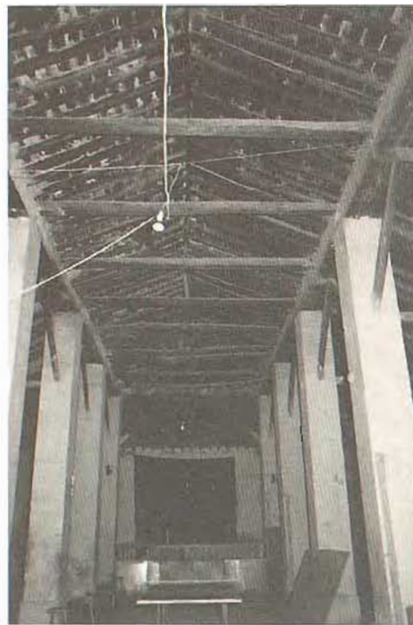
Pósito de Montefrío. Interior recientemente demolido.
