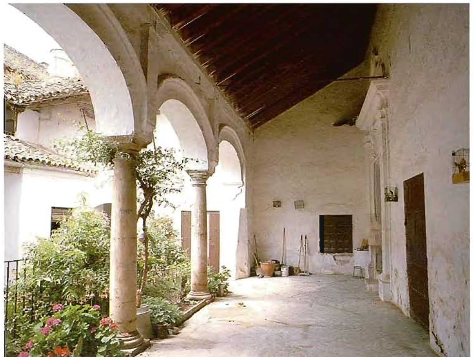
Vista de la arcada frontal del patio, de la que sobresalen los volúmenes de las dos naves de almacén. Galería al patio con una de las portadas, a la derecha, de acceso a los graneros.
