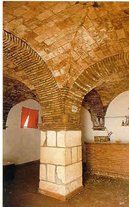
Detalle de una de las portadas e interior de planta baja, destinada probablemente a panera.
