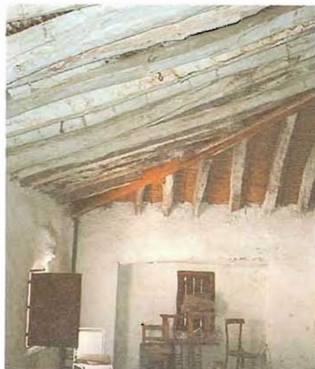
Alzado principal de la Tercia. Detalle del alers e interior del edificio.
