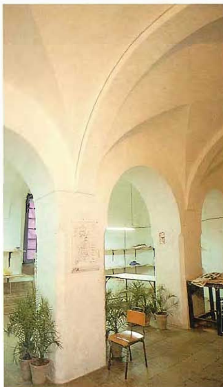
Interior de la nave de almacenamiento situada al fondo del patio.
