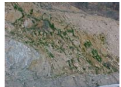
Arriba; Imagen 5. Carretera A-366. Ejecución de hidrosiembras en otoño de 2004.
