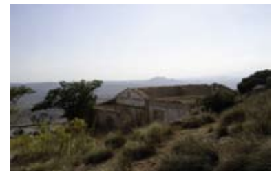
Arriba; Casa de peones camineros. Entorno Parque Natural del Estrecho.
