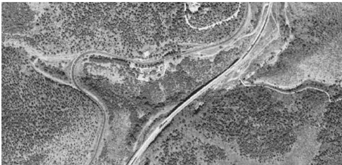
Figura 1. Autovía del Sur, a su paso por el Arroyo de Valdeazores (Jaén). Tramo del camino proyectado por Carlos Lemaur en 1777, desafectado de uso y sin acceso desde la autovía.
