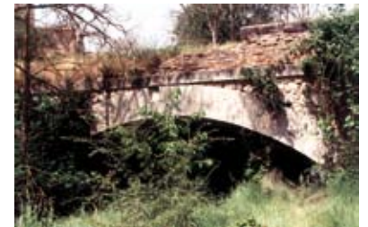
Arriba; Figuras 2 y 3. Tramo del Camino de Valencia, según fue proyectado por Lucio del Valle en 1845, a la altura del Arroyo de la Fuente del Villar (Cuenca). Aspecto actual del trazado y del pontón que salva el arroyo.
