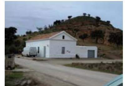
Casa de peones camineros. Entorno Parque Natural Montes de Málaga.
