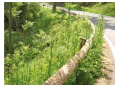
Arriba y centro; Soluciones geotécnicas para el tratamiento de taludes.
