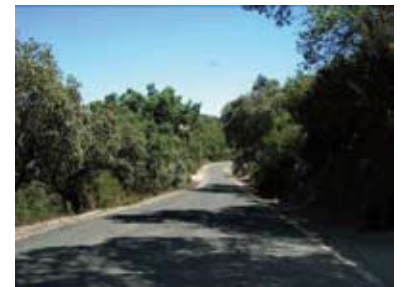
Carreteras de la red autonómica en el entorno de Montoro. La conservación de muretes, aún no sustituidos por biondas metálicas, y el mantenimiento en algunos tramos de una vegetación arbórea que extiende sus copas sobre la carretera son elementos que valorizan el paisaje de la carretera, e invitan a una conducción sosegada, que permita disfrutar del paisaje exterior en aquellos tramos donde las vistas se abren.
