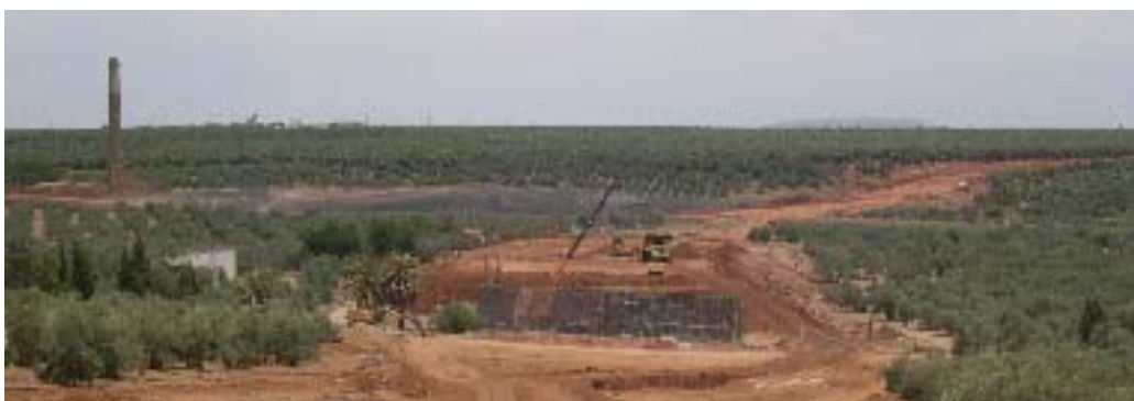
Panorámica de la construcción de la nueva variante E. «Estudio activo de paisaje a través de la inserción de la variante de Linares».
