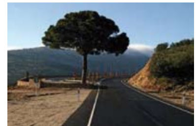
A-369. Ronda-Gaucín. Las características de esta carretera no responden a una tipología convencional.
