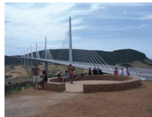
Arriba; El viaducto Millau en la A-75 próximo a Montpellier Abajo; Mirador en el viaducto Millau
