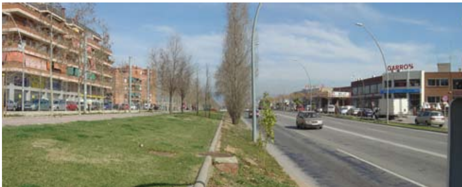
Reforma de la carretera C-246 a su paso por Sant Boi de Llobregat (Herce-EGI 1998): vista de las obras realizadas
