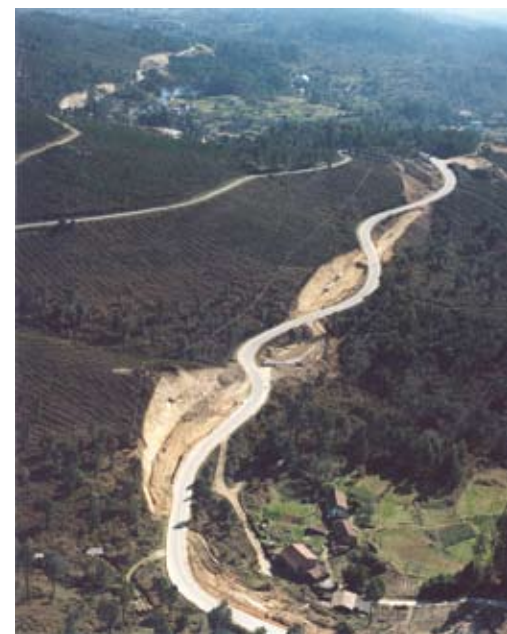
Foto 2. Pérdida de adecuación paisajística por rectificación de trazado
