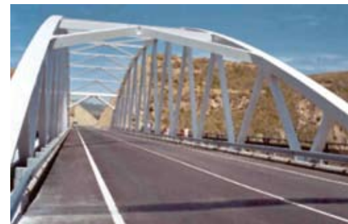
Foto 4. Nuevo puente de acceso a la Alpujarra, Granada. El diseño y la forma rompen radicalmente con sus antecesores, sobre los que está construido, pasando sobre ellos respetando su espacio y el trazado de sus vías, como queriendo reclamar su protagonismo y convertirse por sí mismo en el símbolo y referencia del entorno.
