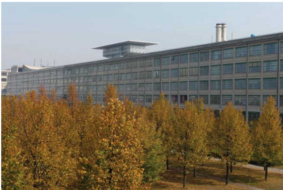
Foto 9. Antigua fábrica FIAT de 1924, // Lingotto, remodelada en 2002
