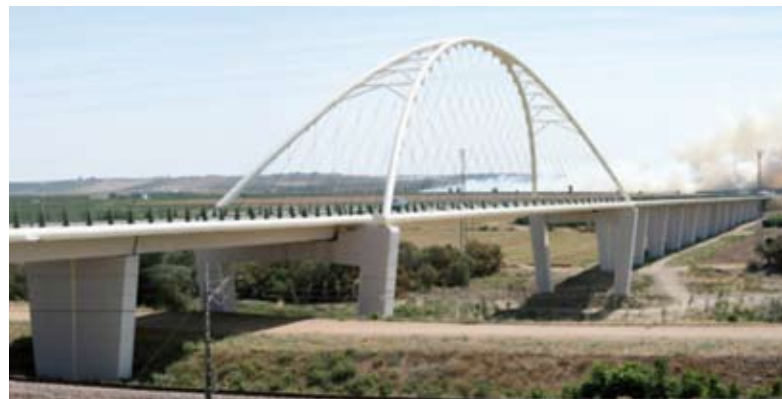
Foto 2. Puente sobre el Guadalquivir en Palma del Río (Plan CERCA de la Junta de Andalucía, 2003)
