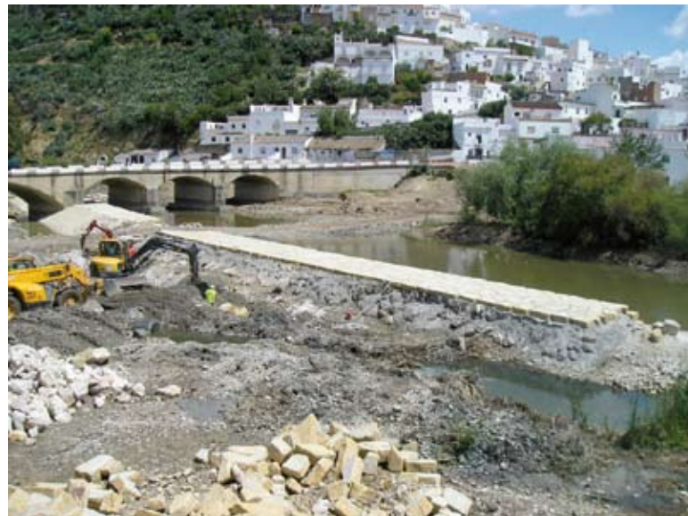
Foto 3. Desviación del cauce del río Guadalete
