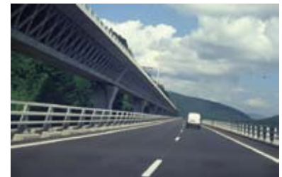
Arriba; Talud en la Autopista del Noroeste en la A-6 de Madrid a Coruña, en el ascenso a Piedrafita Abajo; Solución que independiza la traza de la carretera de la ladera, en una autopista francesa
