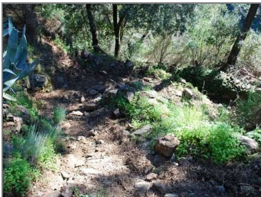
El sendero tiene una buena caja que lo define claramente. Se ha de realizar limpieza de matorral, despedregado y retirada de tierras.
