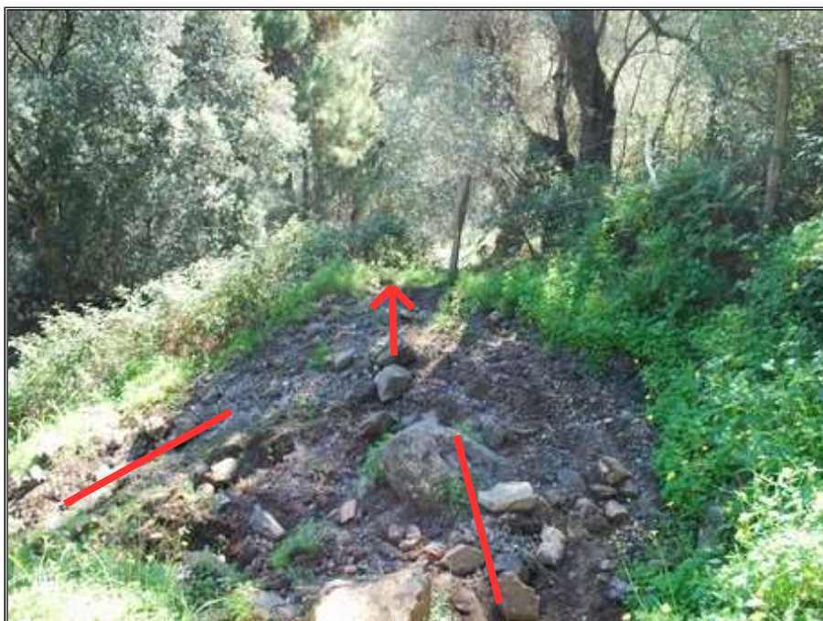
Vista del final del pavimento. Con flecha se marca las salidas de las aguas superficiales. El sendero continúa descendiendo hacia la izquierda.
