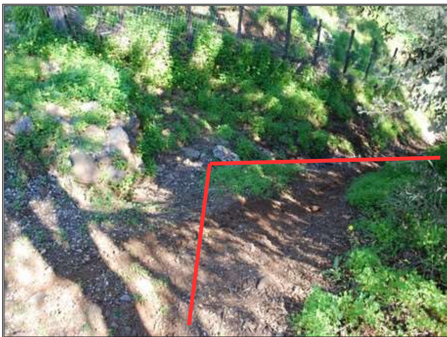
Primer tramo de la rampa de bajada del sendero. En rojo se marca el eje del pavimento chapado de piedras.
