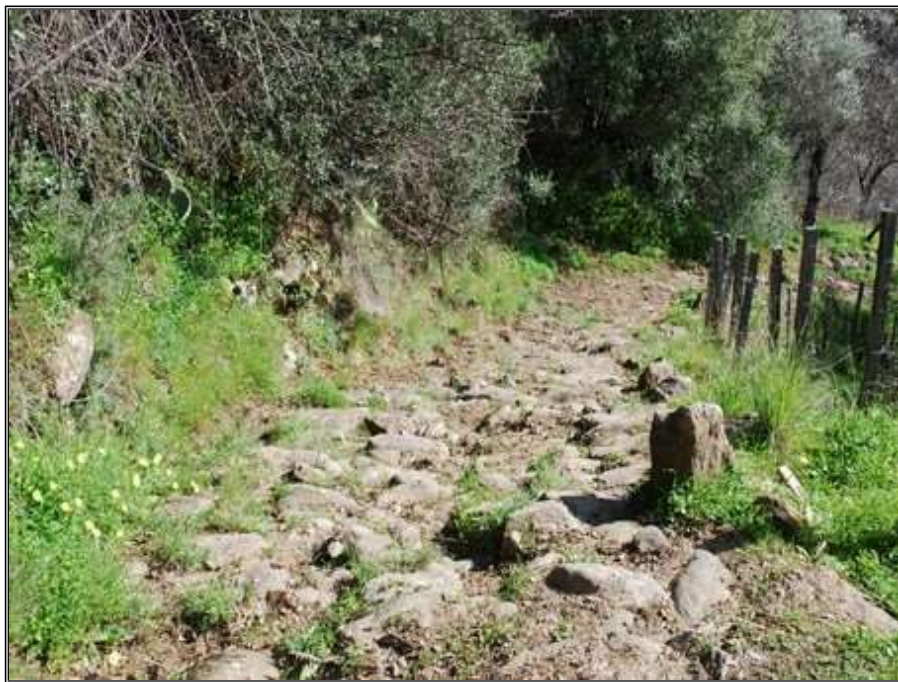
Vista hacia abajo en dirección al Puente 2. En caso de deterioro por el tránsito de maquinaria o materiales hay que reponer el empedrado.
