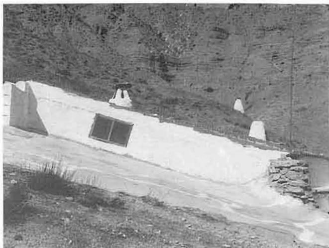
Gorafe. Granada. Refuerzo e impermeabilización de parte del terreno que constituye el techo de la casa cueva. En primer plano puede observarse la ejecución de un lucernario.
