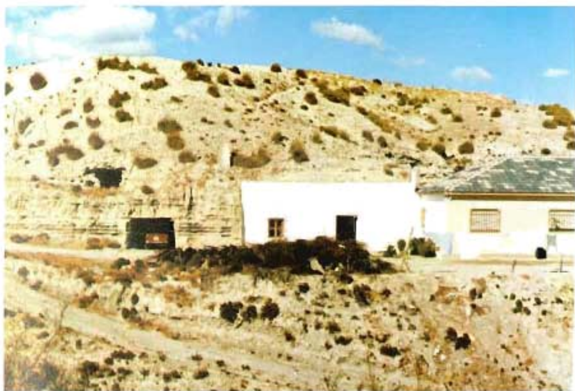
Las Juntas (Cortes de Baza). Cueva-cochera en la que se puede apreciar la forma del techo totalmente plana, aprovechando la disposición horizontal de los estratos.
