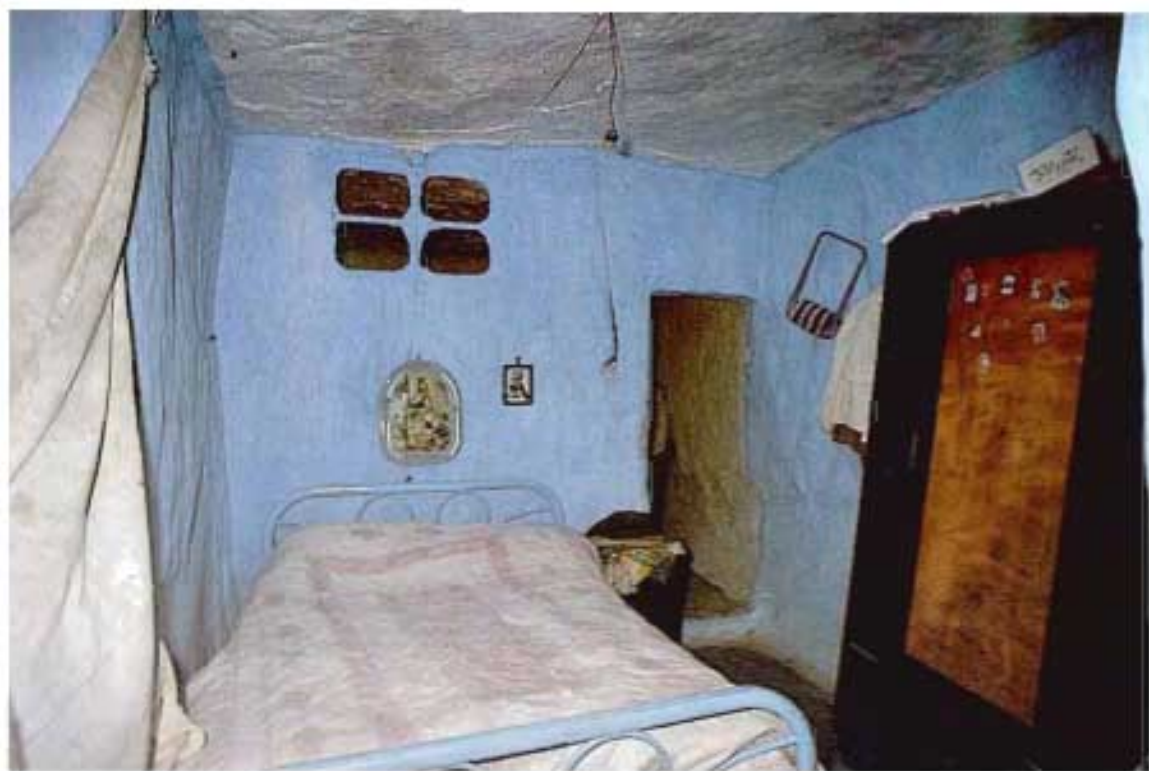
Almería. Habitación interior utilizada como dormitorio. Obsérvese la falta de puertas, separando estancias y la abertura del muro para conseguir una leve corriente de aire en el interior de la vivienda.
