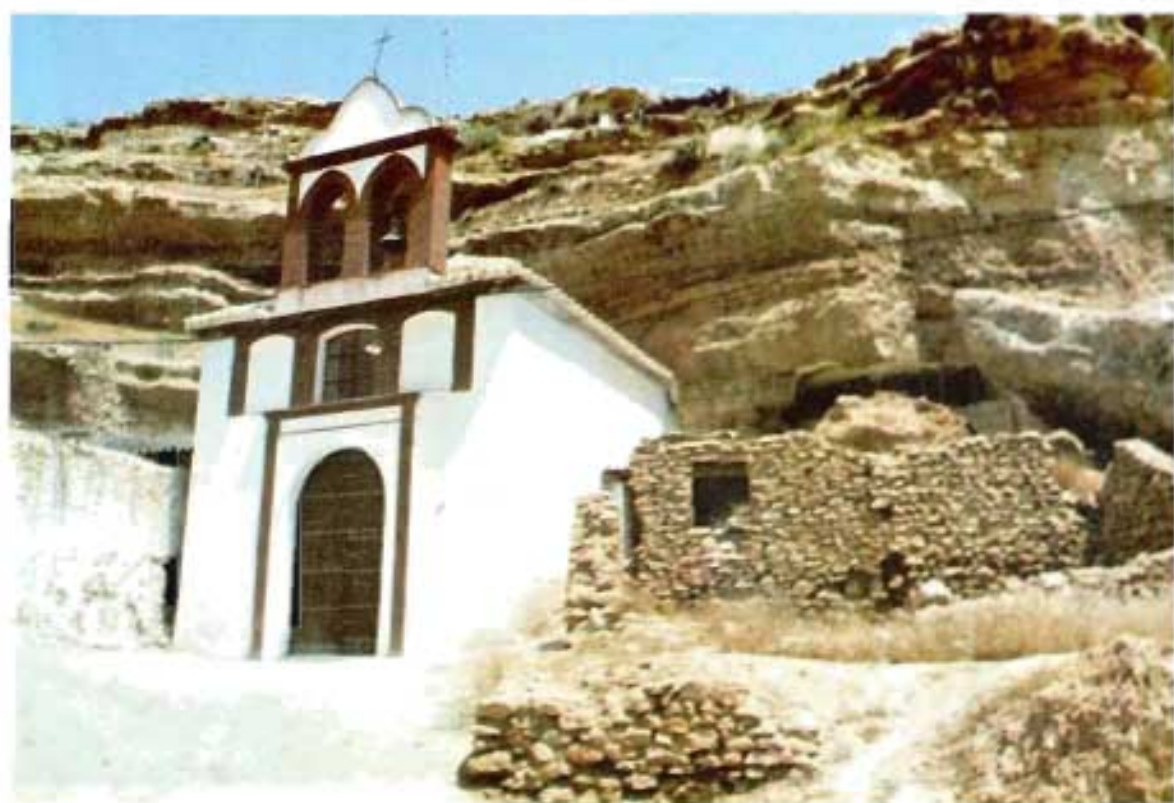
Barranco de Belerda (Gualfex). Iglesia nueva con parte excavada. A su derecha aparecen ruinas correspondientes a la antigua iglesia totalmente excavada.
