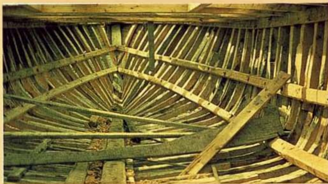
Construcción de una embarcación.
