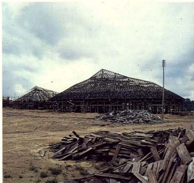
Centro de Protección Ambiental, Balbina.
