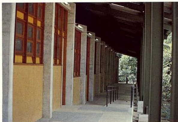
Circulación de las aulas (desniveles en rampa).
