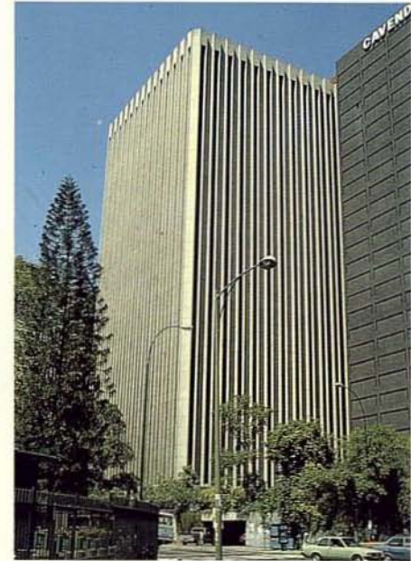
Edificio Cavendes, 1978, núcleo central y estructura tubular.
