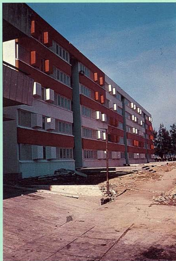
Conjunto de viviendas en La Habana. Sistema LH, 1970.
