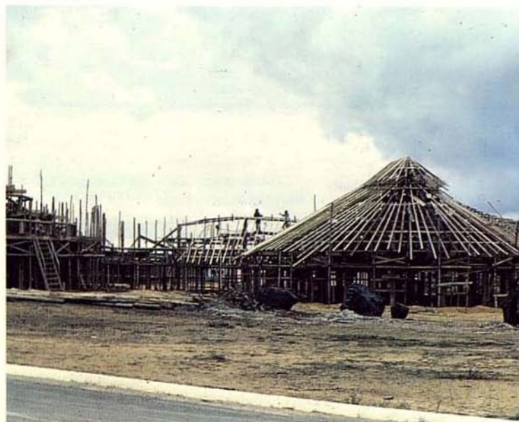
Vista de los laboratorios durante su construcción.
