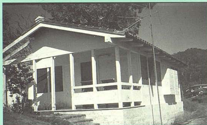
Conjunto de viviendas campesinas, Cooperativa en Cayabós, Provincia Pinar del Río, 1970.
