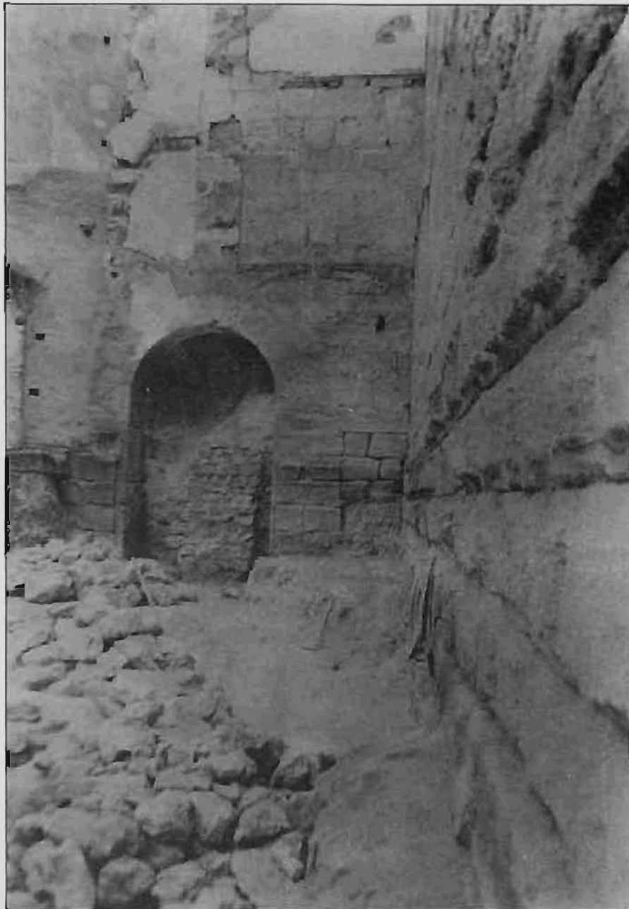
FIGURA 32 Obras de la Poterna y la Torre del Oro
