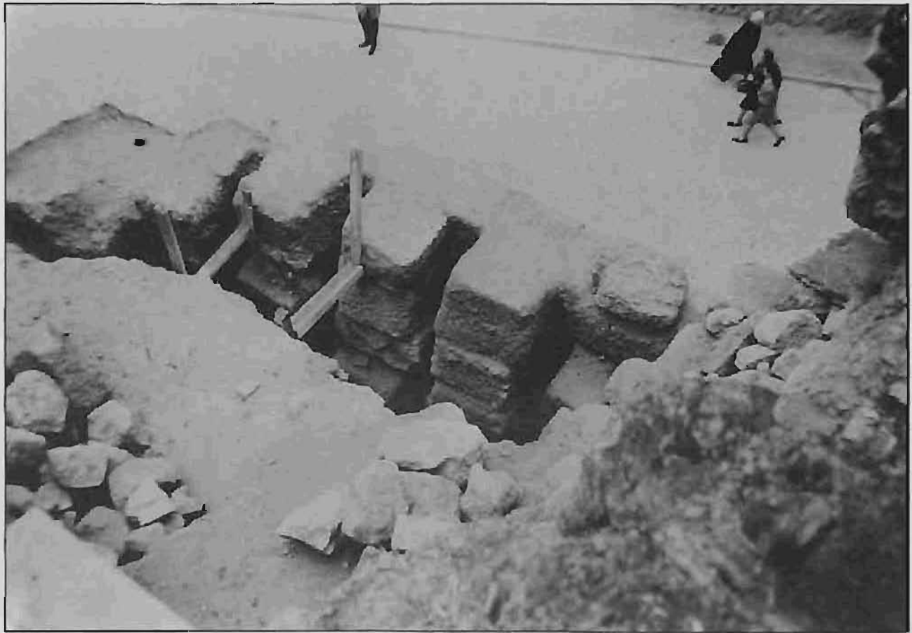
FIGURA 29 El ángulo de la terraza NW en obras
