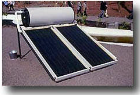
Ilustración 4: Panel Solar Térmico
