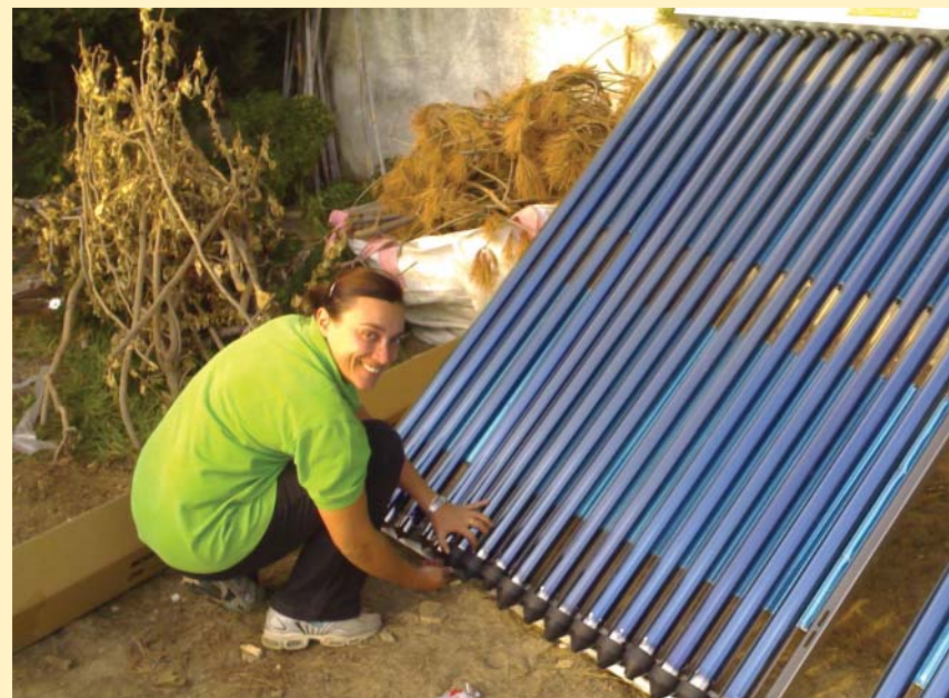
Fuensanta instalando uno de sus modelos de paneles energéticos)
