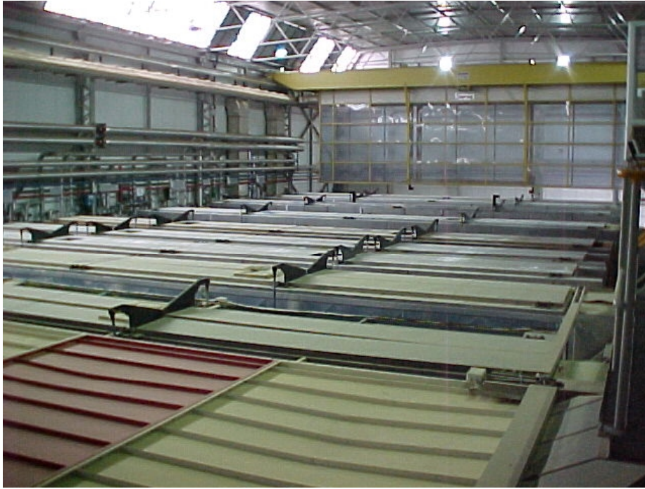
SACESA. Baños de tratamientos químicos (14x3x1 metros)
