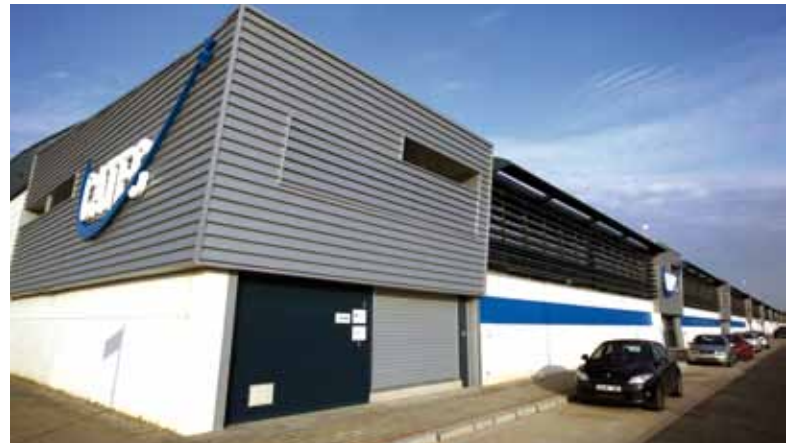
INSTALACIONES DE CATEC EN AERÓPOLIS
