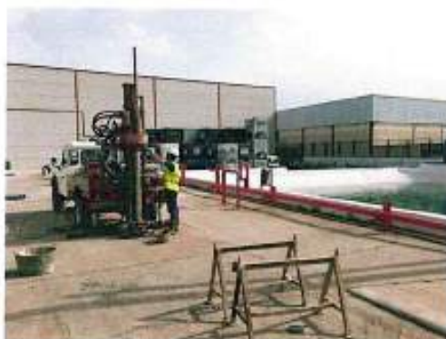
ZONA DE TRABAJO S-4Bis
