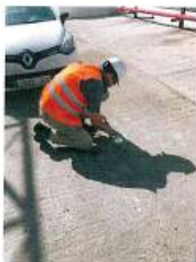
ZONA DE TRABAJO S-4Bis
