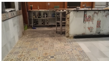
ZONA DE BARRA DEMOLIDA
