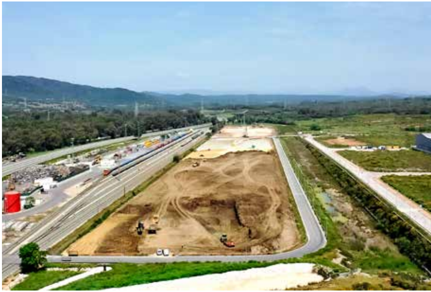
1ª fase de las obras complementarias de urbanización de San Roque. Mejora de Terrenos.
