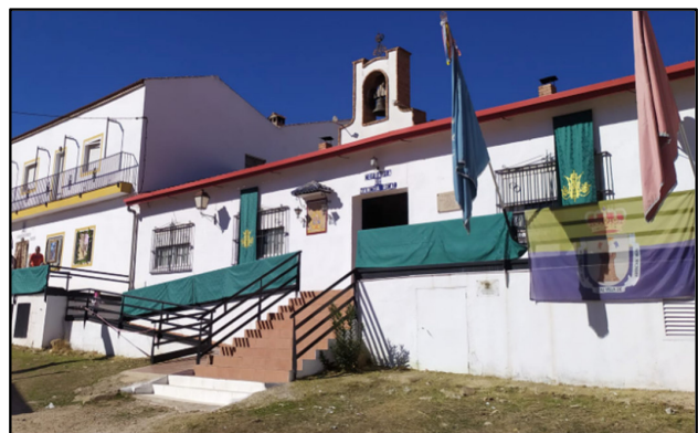
FACHADA MANCHA REAL
