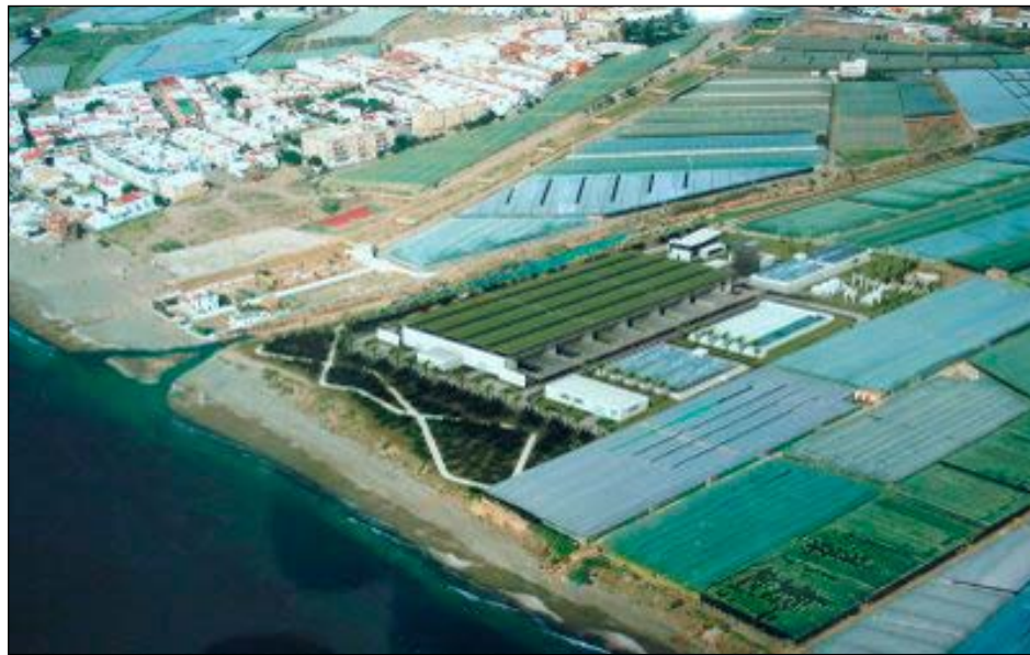
Fotografía 9. Desaladora. Campo de Dalías. (Almería).
