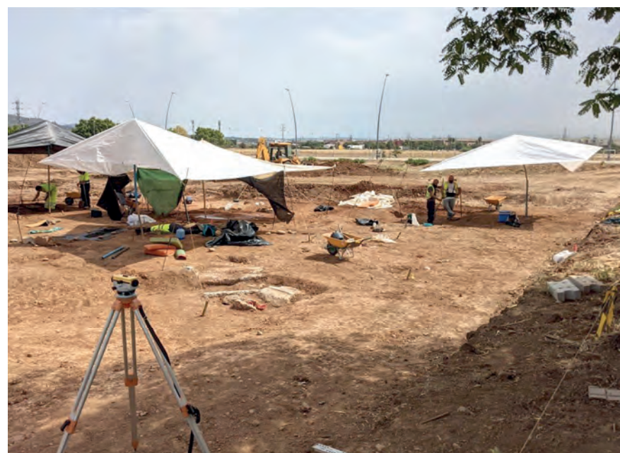
Ejecución de la Nave Multicliente L4 en el Área Logística de Córdoba
