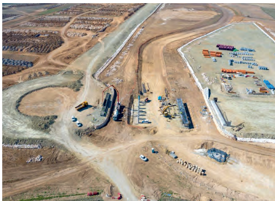
Obras 1ª fase del Área Logística de Antequera.
