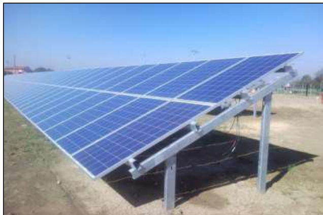
Imagen 6. Ejemplo de módulos fotovoltaicos y estructura solar fija
