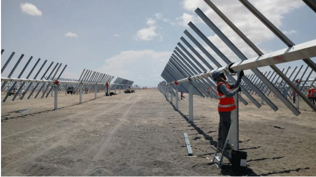
Figura 3.2.11.a. Montaje de estructura seguidor con perfiles hincados directamente en el terreno. Fuente: Modificados de los Proyectos de Ejecución de las Plantas Fotovoltaicas Venta Angulo, Los Llanos y Las Canteras. TT.MM. Baza y Caniles (Granada).
