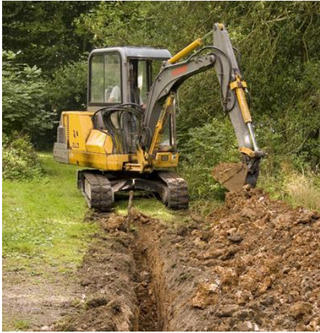
Figura 3.2.10.a. Excavación de zanjas. Fuente: Modificados de los Proyectos de Ejecución de las Plantas Fotovoltaicas Venta Angulo, Los Llanos y Las Canteras. TT.MM. Baza y Caniles (Granada).
