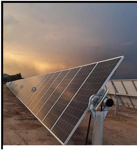
Figura 3. Seguidor fotovoltaico
