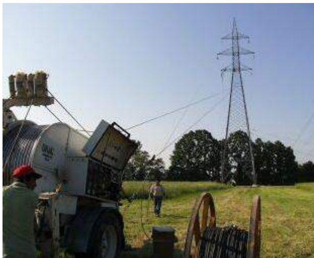
Ilustración 42. Tendido del cableado eléctrico mediante máquina de tracción
