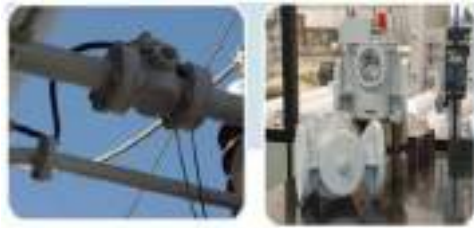
Ilustración 21. Relé Buchholz para transformador de potencia (Fuente: Externa)
