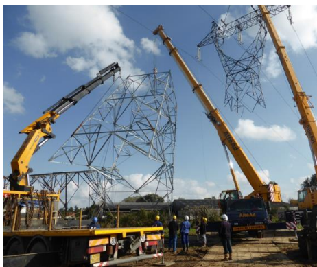
Ilustración 12. Montaje e izado de los apoyos
