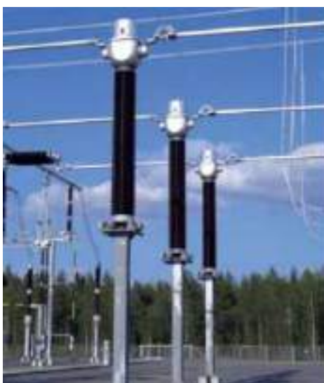
Ilustración 7. Transformadores de intensidad (Fuente: Externa)
