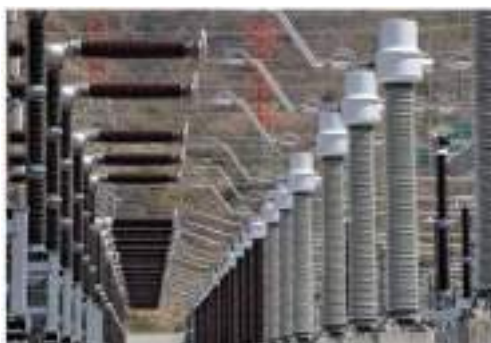
Ilustración 8. Transformadores de intensidad CA 420 kV
