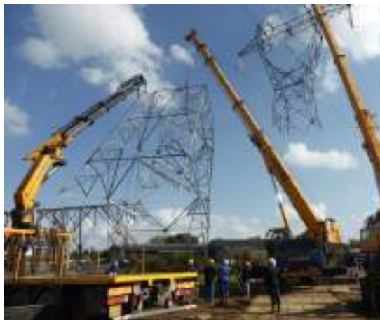
Ilustración 41. Montaje e izado de los apoyos
