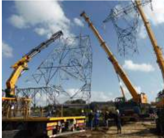
Ilustración 20. Montaje e izado de los apoyos
