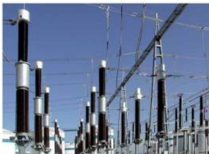
Ilustración 5. Transformadores de tensión inductivos en 400 kV
