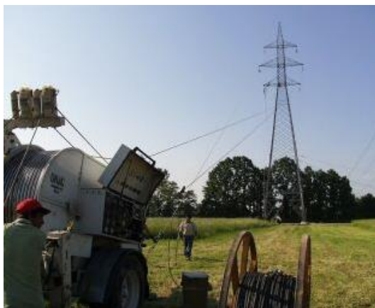
Ilustración 13. Tendido del cableado eléctrico mediante máquina de tracción
