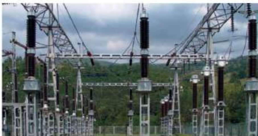
Ilustración 17. Transformadores de tensión capacitivos (Fuente: Externa)
