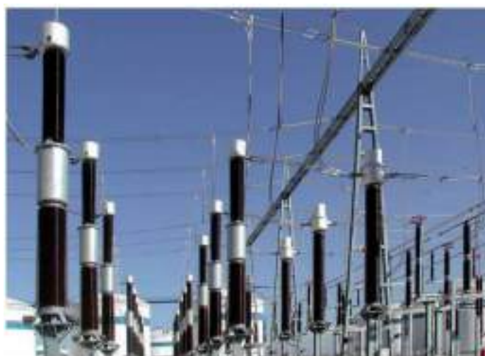
Ilustración 16. Transformadores de tensión inductivos en 400 kV
