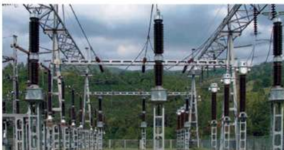
Ilustración 6. Transformadores de tensión capacitivos (Fuente: Externa)
