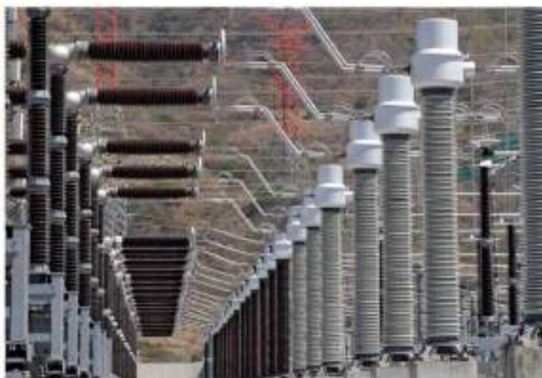
Ilustración 19. Transformadores de intensidad CA 420 kV
