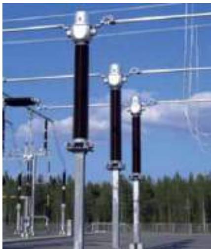
Ilustración 18. Transformadores de intensidad (Fuente: Externa)
