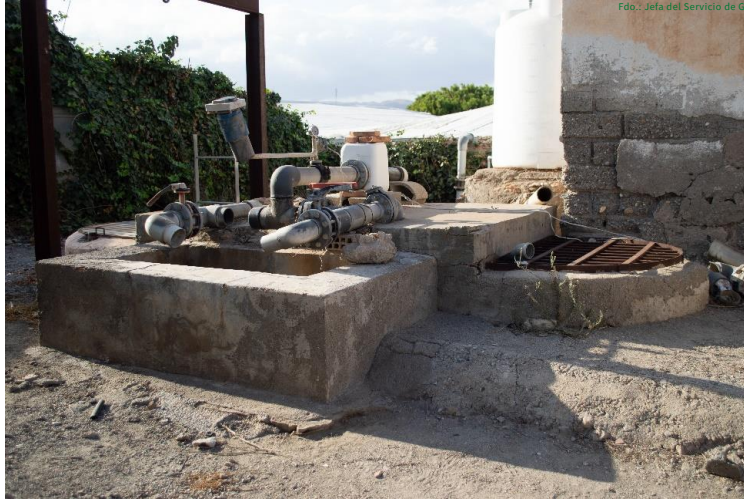
Imagen 70: Antigua noria de sangre con motor eléctrico.
