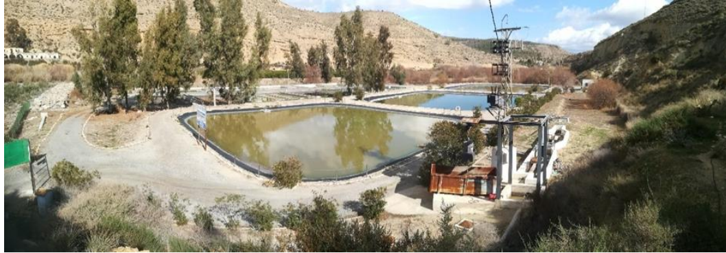
Imagen 49: EDAR de Alhama de Almería en deficiente estado de conservación y funcionamiento.
