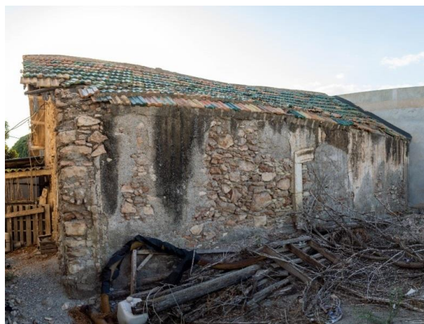
Imagen 68: Caseta que albergaba máquina de vapor para extraer agua de Pozo de Bover.
