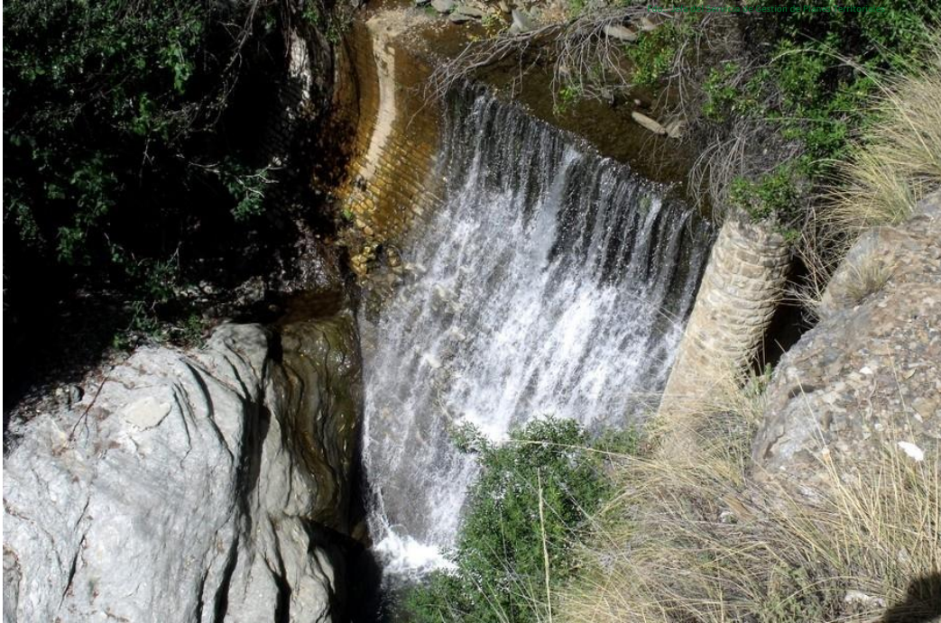
Imagen 13: Presa la Murilla.
