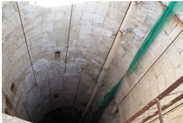
Imagen 67: Pozo ejecutado por Bover en la vega de Almería
