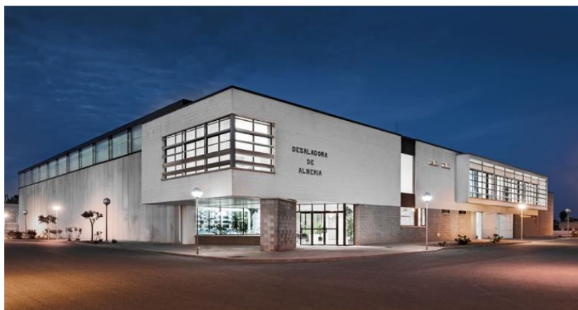
Imagen 73: Instalaciones de la desaladora de Almería. Fuente: Informe anual de operación y mantenimiento Abengoa.
