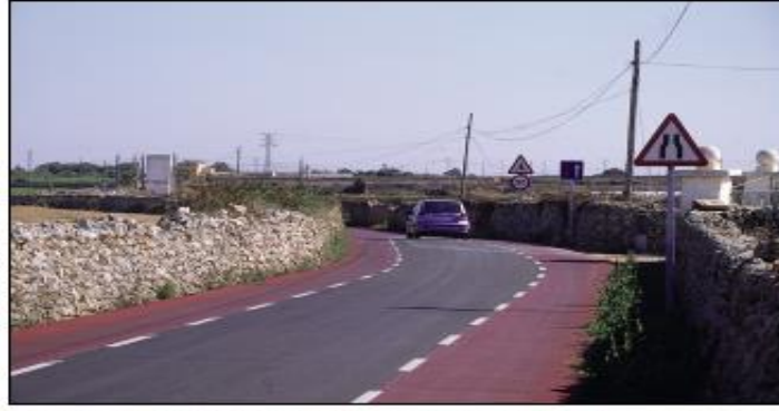
Carretera con carril central único para los dos sentidos de circulación y arcenes para los modos no motorizados. Menorca.
