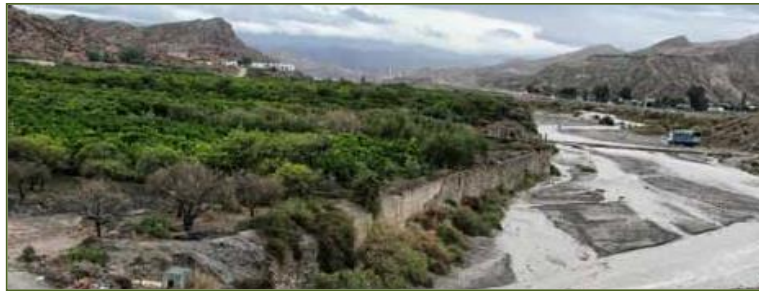
Ilustración 14. Escorrentía de aguas de tormenta en el río Andarax.
