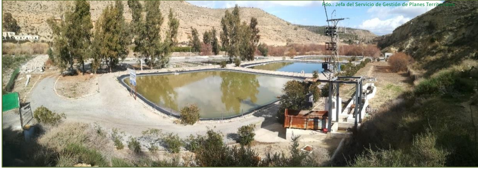
Ilustración 131. EDAR de Alhama de Almería en deficiente estado de conservación y funcionamiento.
