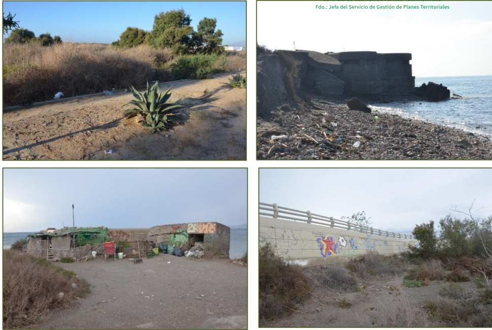
Ilustración 133. Fotografías que muestran la degradación del cauce en la desembocadura.
