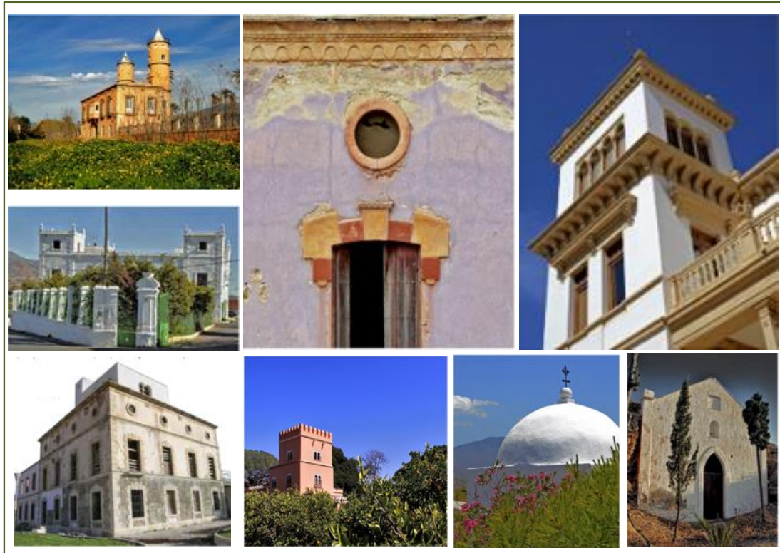
Ilustración 68. Varios ejemplos de arquitectura singular en el ámbito
