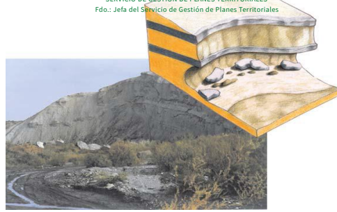
Ilustración 23. La erosión lateral de la base del talud en áreas de meandro provoca la inestabilidad y posterior caída de los bloques superiores
