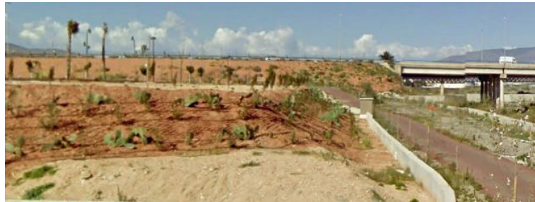
Foto 4. Puente ciego sobre el río que dificulta la salida del barrio de El Puche.
