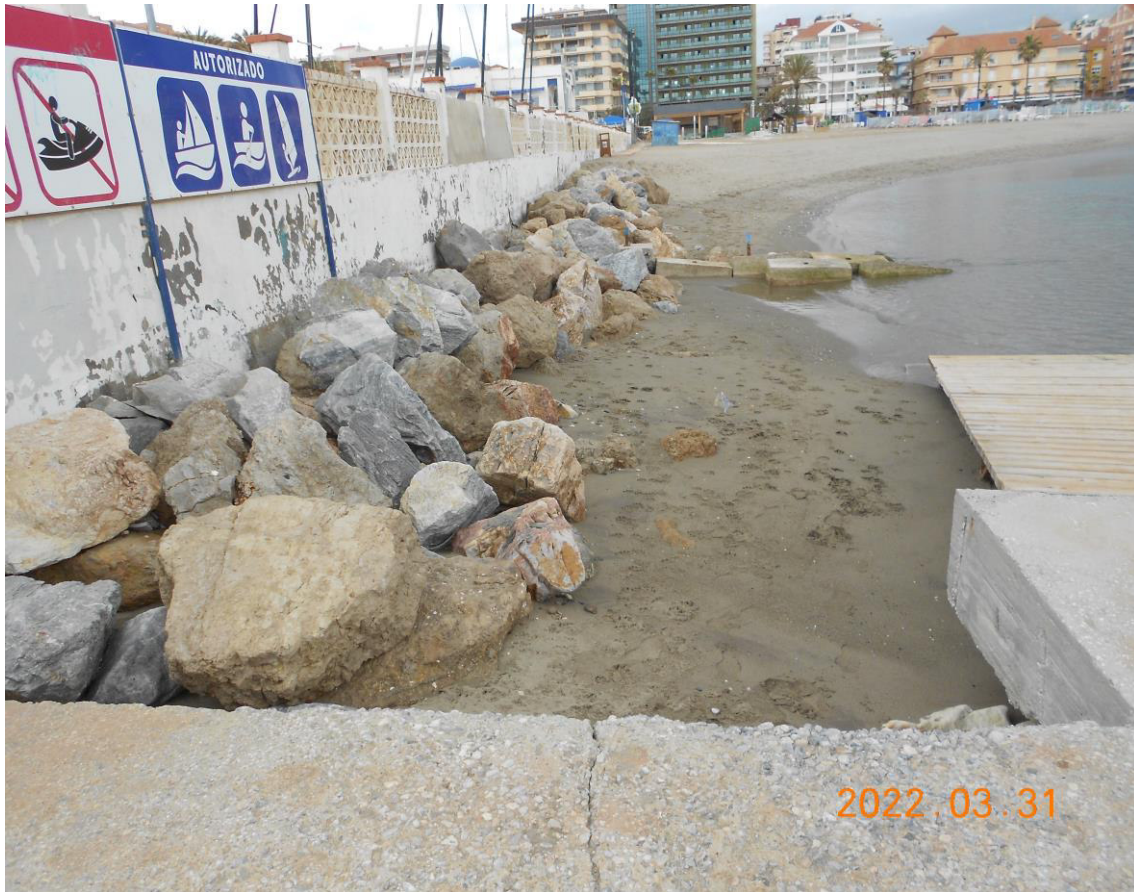
Zona donde se construirá la plataforma
