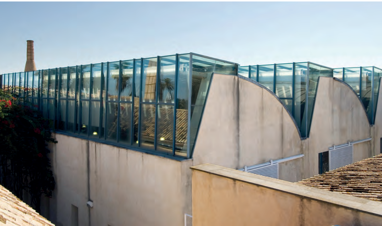
Cubiertas de algunos talleres de restauración del IAPH. Foto Fondo Gráfico IAPH, Juan Carlos Cazalla
