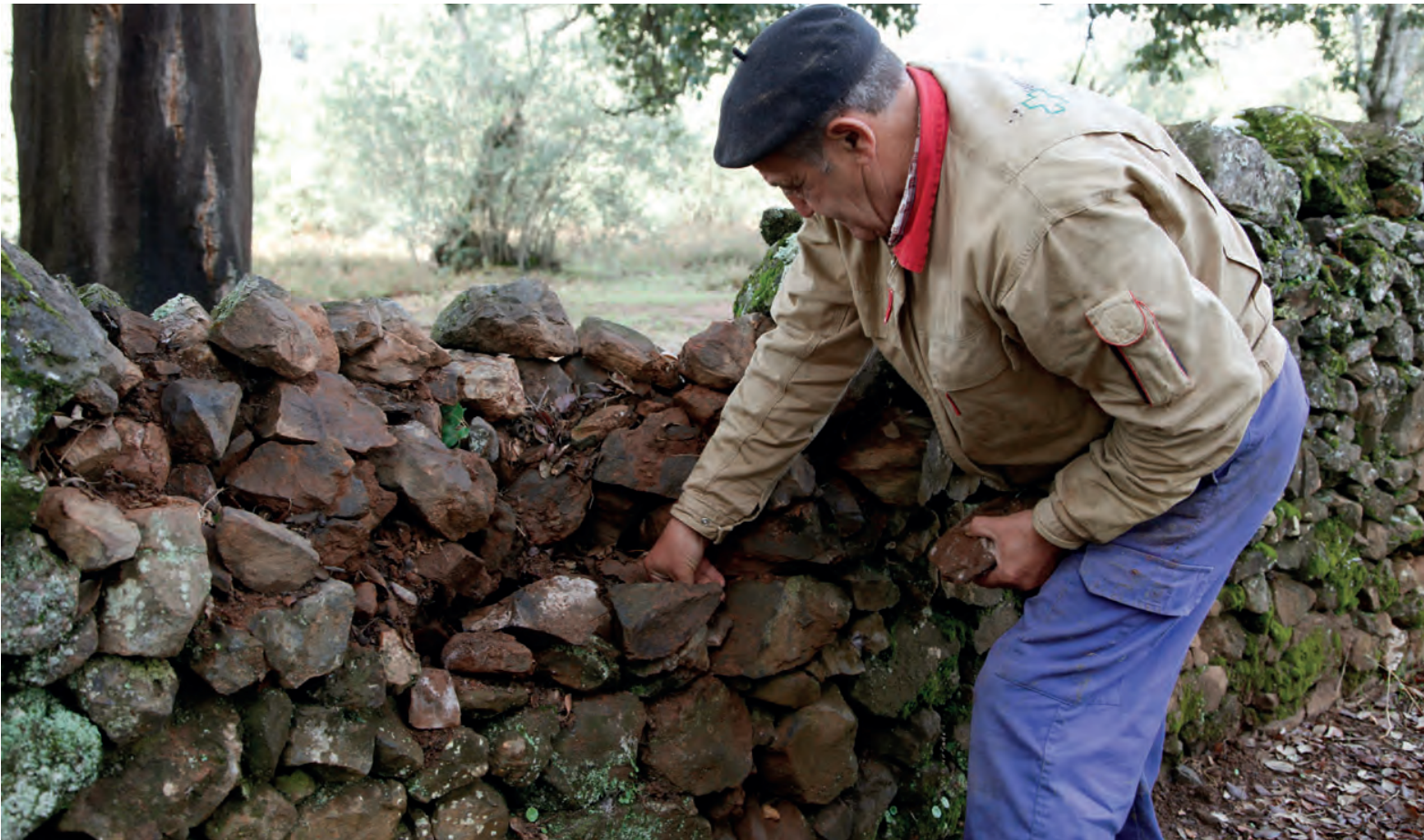
Construcción de muro en piedra seca en Aracena (Huelva). Foto Fondo Gráfico IAPH, Aniceto Delgado Méndez
