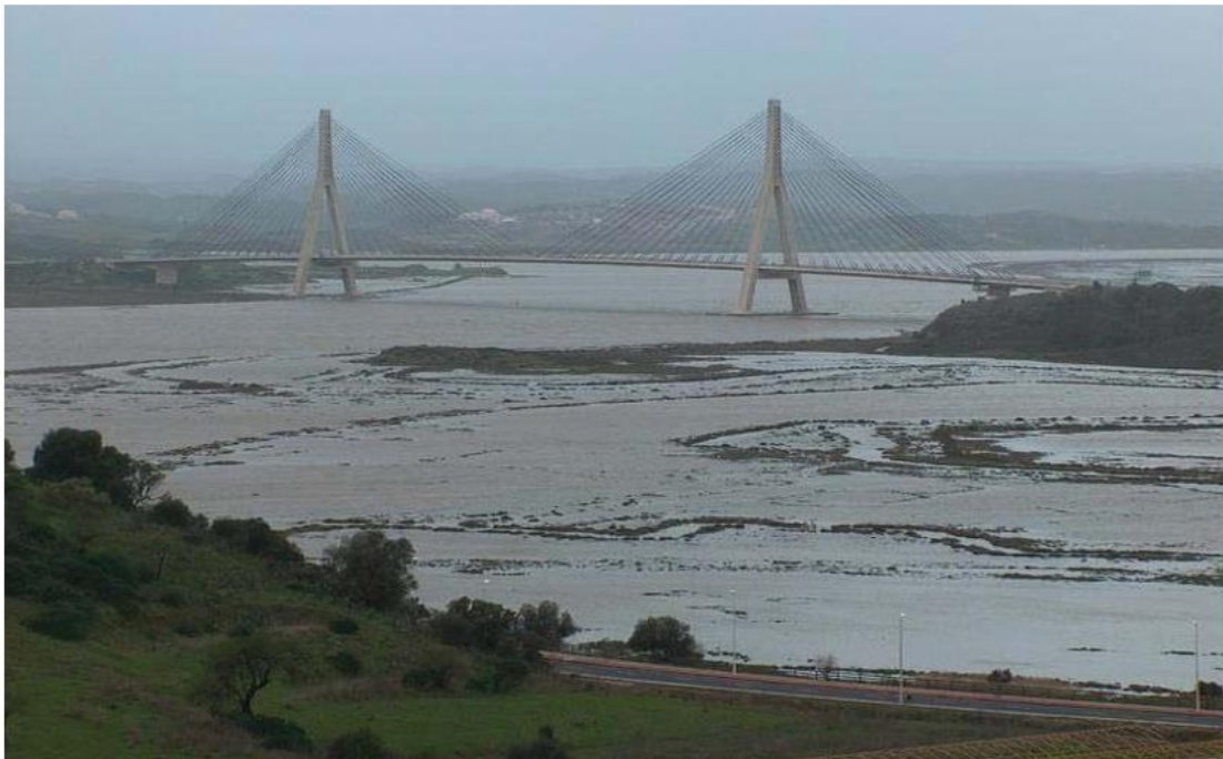
Figura 12. Fotografías de una inundación fluvio-marina en el estuario bajo del Guadiana en 2010
