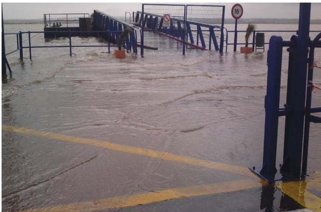
Figura 13. En la imagen se observa el rebose de los pantalanes del transbordador a Portugal
