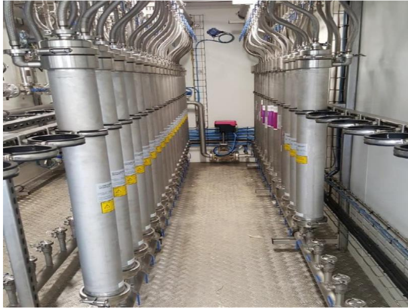
Ilustración 4-17. Upgrading de biogás por membranas (Propio)
