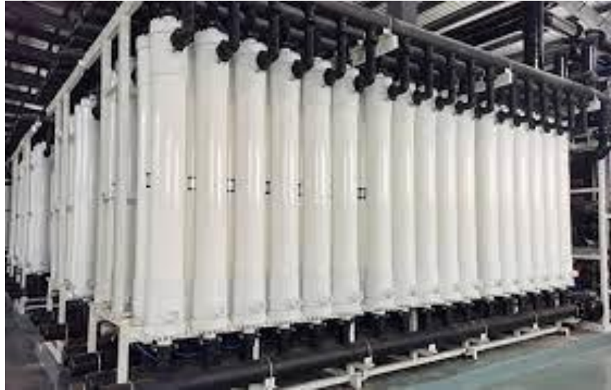
Ilustración 4-26: Instalación de ultrafiltración.
