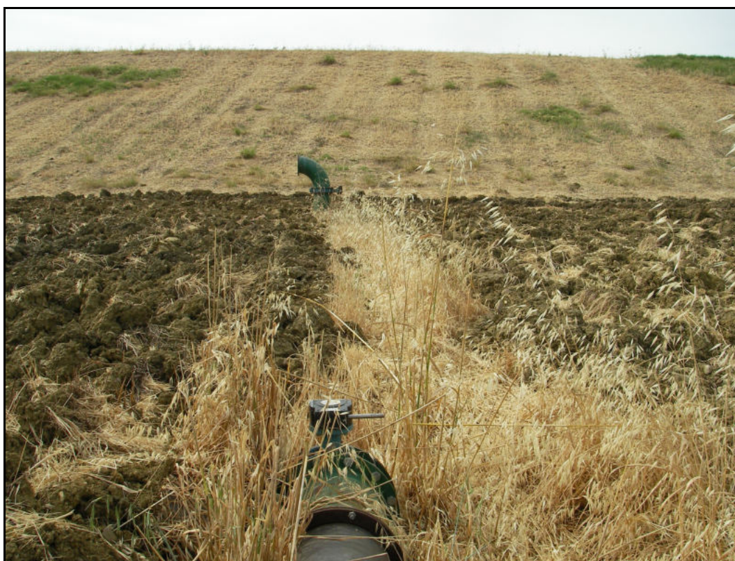
4.- Talud exterior del muro y toma de agua y desagüe de fondo.
