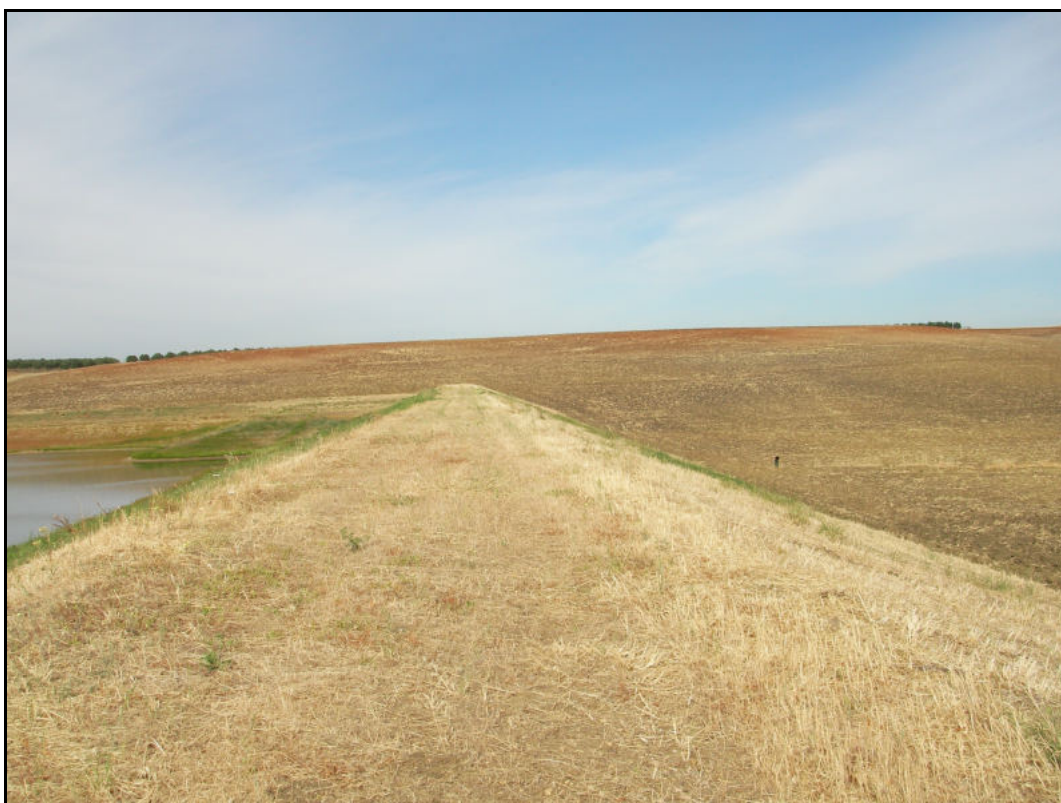
2.- Muro de presa: Pasillo de coronación.
