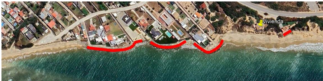
Actuaciones de protección del talud con escollera realizadas en el entorno
