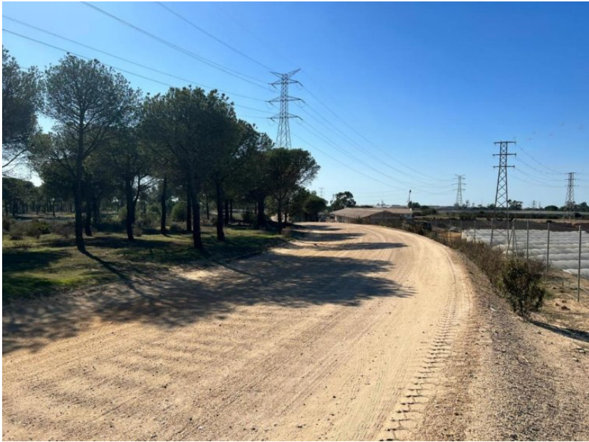
Vista al sur-suroeste del cruce de la conducción con el camino existente
