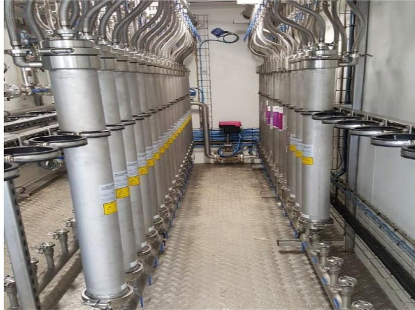
*Ilustración 4-17. Upgrading de biogás por membranas (Propio)*
