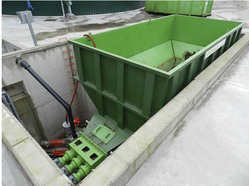
*Ilustración 7-1. Tolva de recepción con tornillos de extracción (Propio)*
