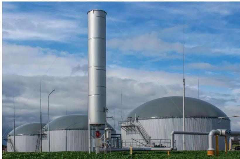
Ilustración 4-13. Antorcha de seguridad (Propio)
