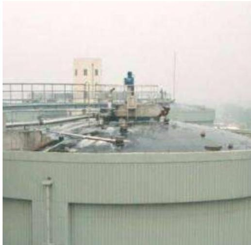
*Ilustración 4-11. Sistema de agitación SCABA (Propio)*
