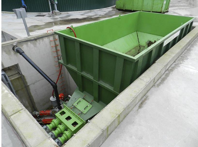
*Ilustración 4-3. Tolva de recepción con tornillos de extracción (Propio)*
