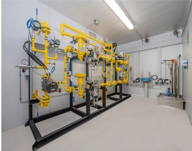
Ilustración 4-18. Módulo de inyección a red (Propio)
