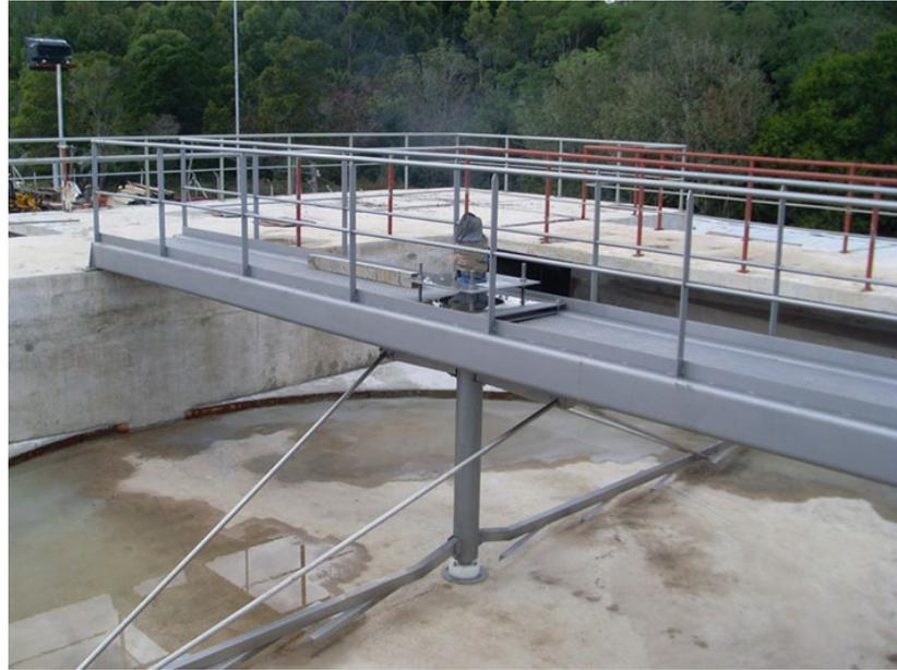
Ilustración 4-8. Sistema de separación de arenas (Propio)
