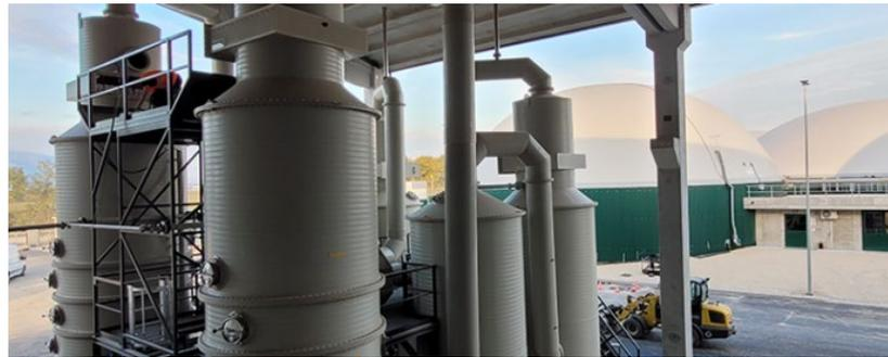
*Ilustración 4-25. Sistema de recuperación de nitrógeno*
