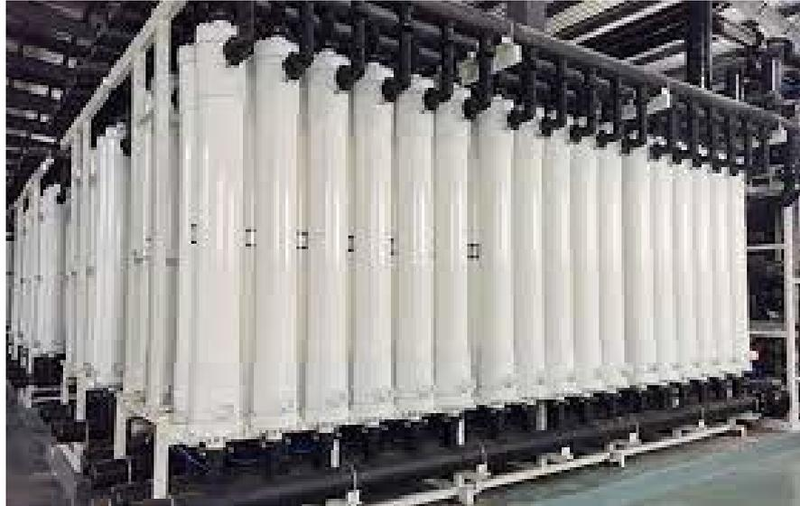
*Ilustración 4-26: Instalación de ultrafiltración.*
