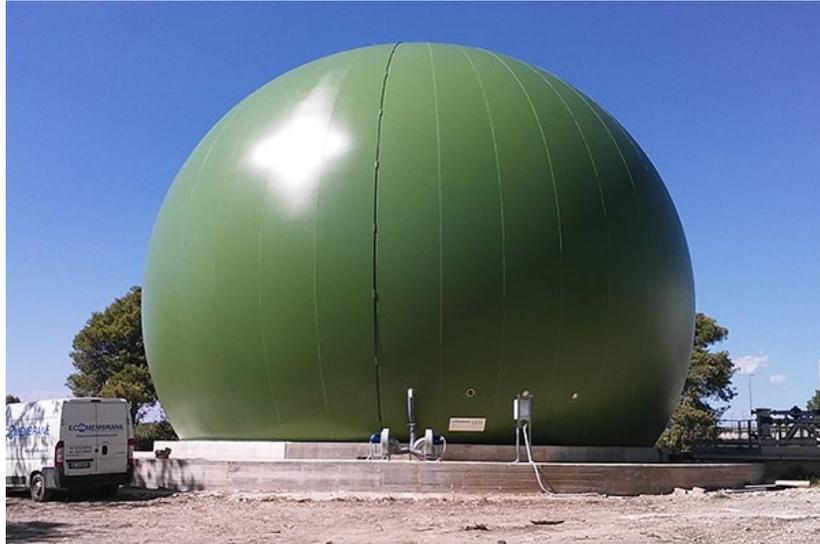
Figura 1. Membrana de almacenamiento de biogás
