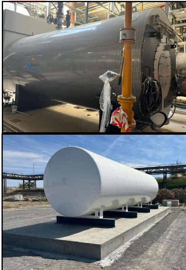
Ilustración 34: Caldera tricomcombustible (arriba) y depósito de gasóleo (abajo) instalados.
