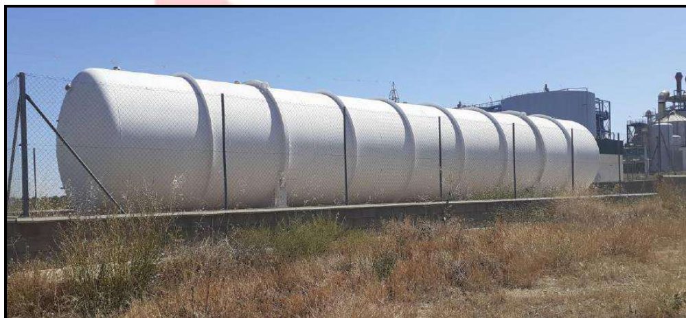
Ilustración 7: Nuevo depósito GNL de 210,5 m 3 instalado.
