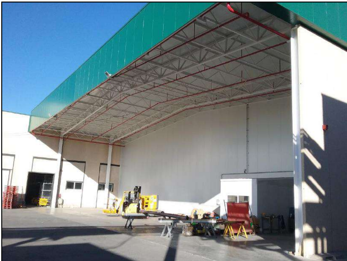
Ilustración 21: Voladizo objeto de cerramiento perimetral.
