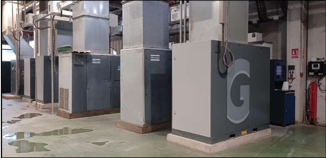
Ilustración 27: Compresores de aire comprimido instalados en sala hidráulica.
