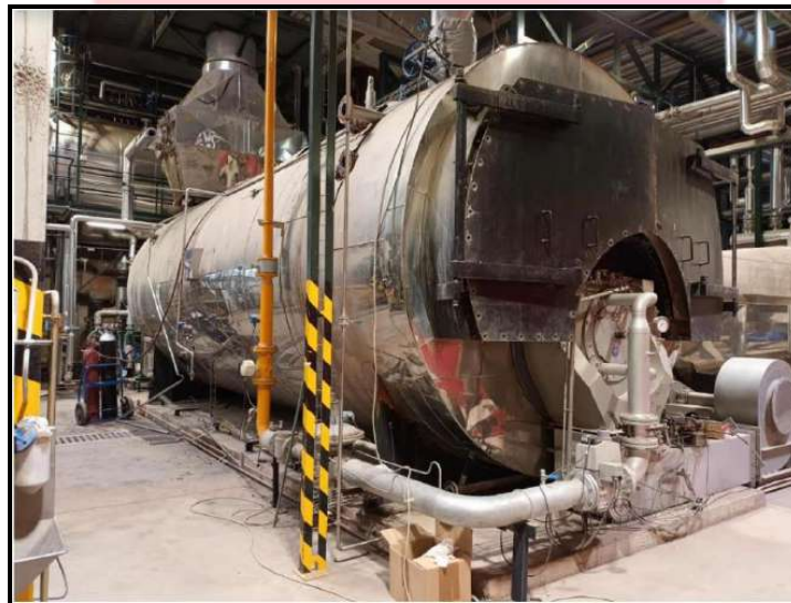
Ilustración 31: Caldera convencional existente antes de su desmantelamiento.
