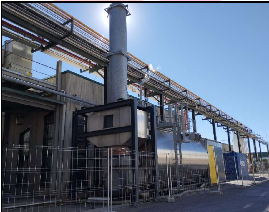
Ilustración 32: Caldera mixta temporal ubicada en exterior.
