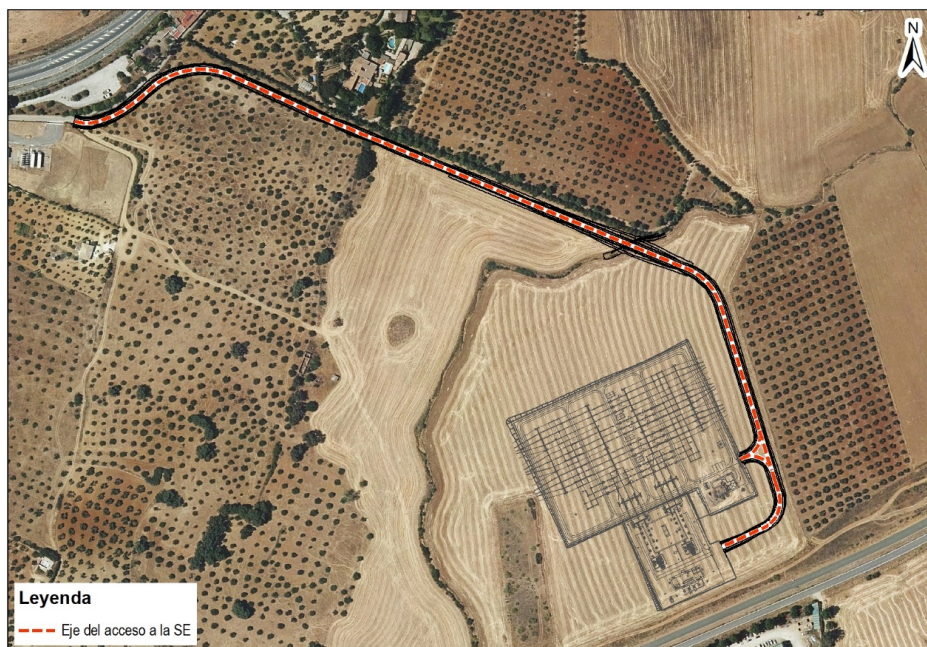
Figura 3. Acceso a la SE Ronda 400 kV
