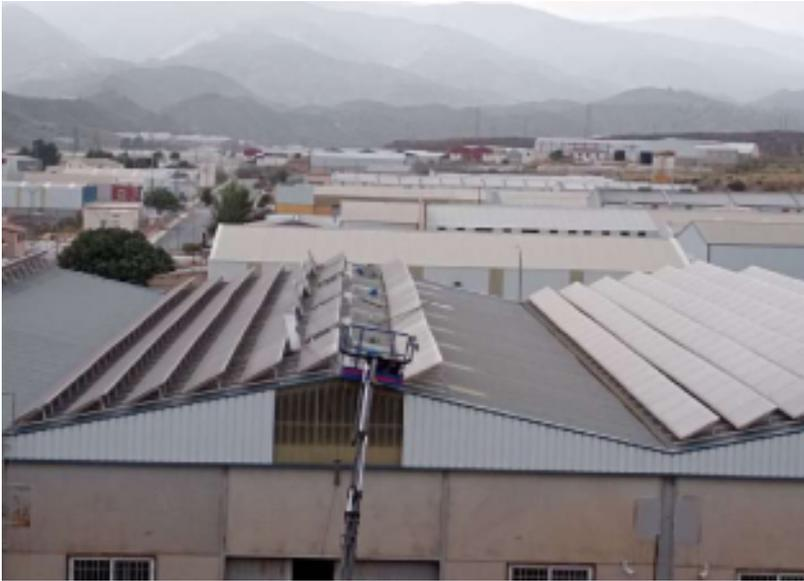
Cubierta no transitable de la nave y canasta del camión grúa para el acceso. La cumbrera se encontraba a 9 metros de altura y estaba conformada por chapas de acero galvanizado y de policarbonato translúcido.
