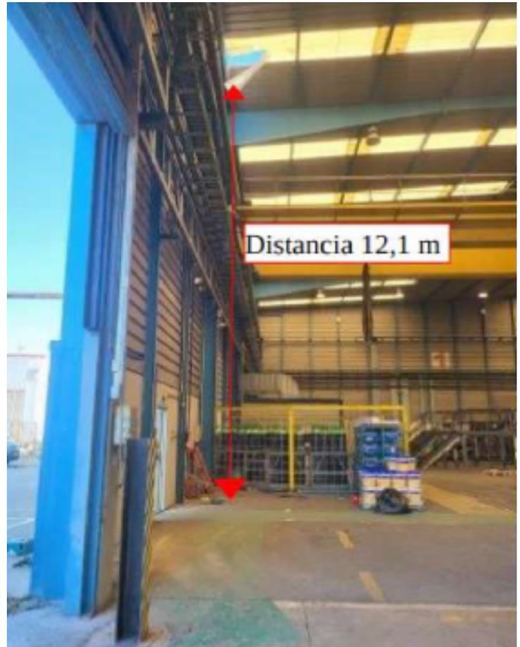
Se observa la placa traslúcida por donde se precipita el trabajador. Llevaba arnés anticaída con dos ganchos de anclaje, pero no estaba anclado a ningún sitio.
