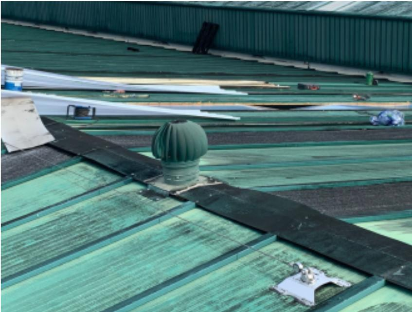
Zona de la cubierta donde se realizaba el trabajo de sustitución de placas lucernarios de policarbonato. Se observa la línea de vida de acero certificada.
