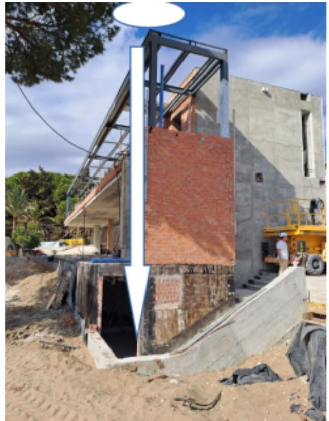
Situación y trayectoria de caída del trabajador, desde lo alto de la estructura metálica hasta el foso de hormigón que da acceso a la planta sótano.
